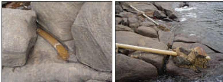
La merde venant des toilettes est évacuée directement sur le rivage par les canalisations, et gagne la mer à marée haute. Sierra Leone
