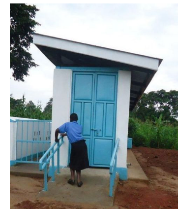
Bloc sanitaire avec toilette étudiée, doté d'une rampe et d'un chemin d'accès plane. Photo : Plan International
