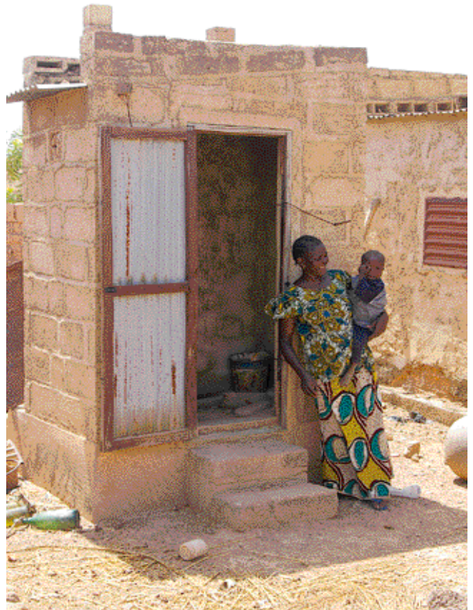
70 toilettes UD ont été construites entre 2003 et 2005
