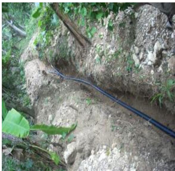
Utilisation préférentielle du PEHD dans les localités de la Grande-Anse. Ici, pose de 2 x 150 ml de tuyaux sur le lot 2. L'utilisation de PVC aurait nécessité 50 barres de 6 mètres, avec autant de points de collage contribuant à augmenter le risque de fuite.
