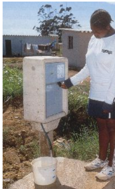
Illustration 7: Un autre modèle de borne fontaine prépayée (Afrique du Sud)
