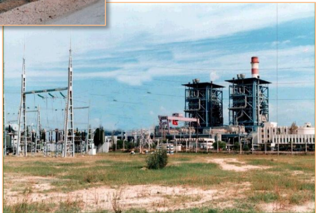
Centrale à cycle combiné de Souss (360MW)
