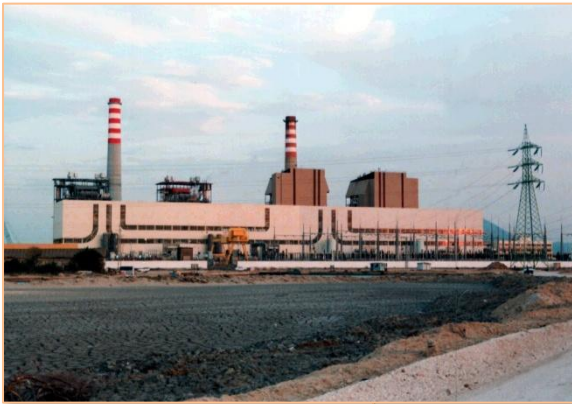
Centrale thermique de Rades (640 MW)
