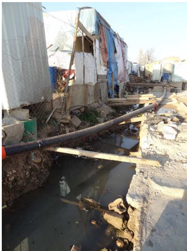
Canal d'exutoire de latrines (ITS près de Zhalé - janv.17)
