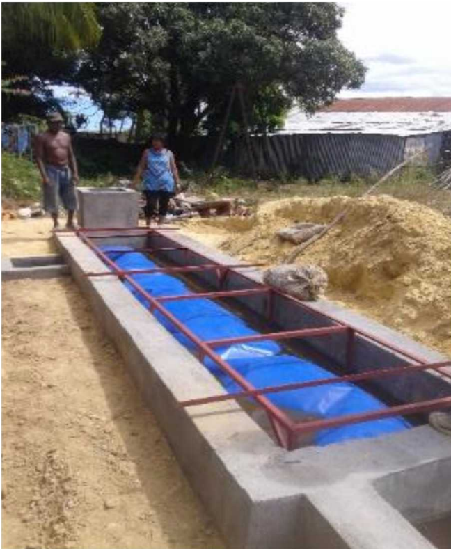
Biodigesteur modèle Jiro à dôme flottant
