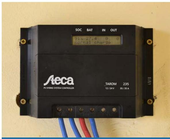
La fonction principale des régulateurs dans le système est de protéger les batteries. Les panneaux photovoltaïques, les batteries et l'équipement d'usage de chaque service sont branchés à un régulateur.
