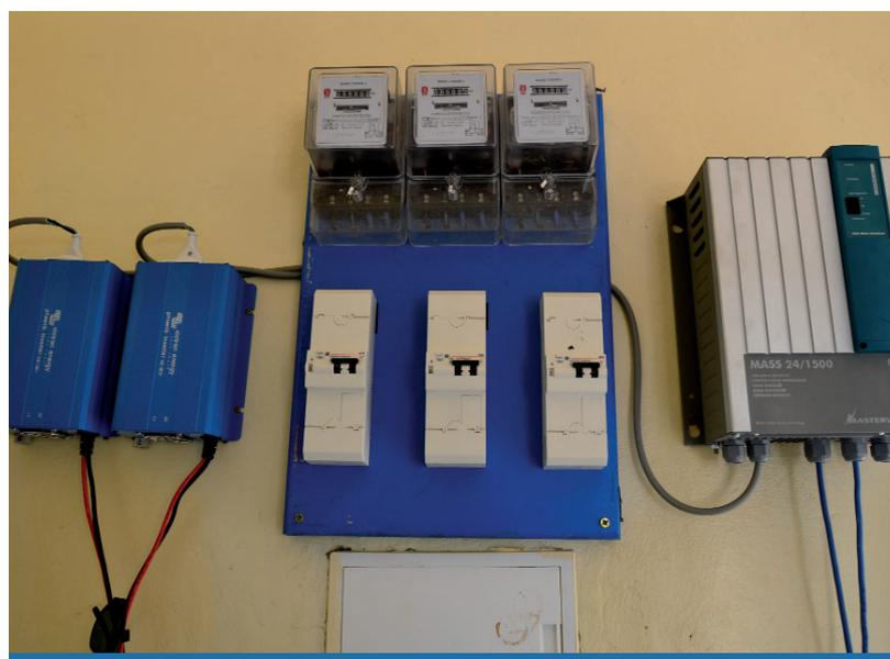
Les panneaux sont branchés à un régulateur de 35 A / 24 V qui permet de protéger les quatre batteries solaires de 180 Ah/12 V chacune.
