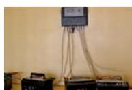
Une station de charge de batteries à 8 voies en 12 V et des kits d'éclairage individuels rechargeables à la station
