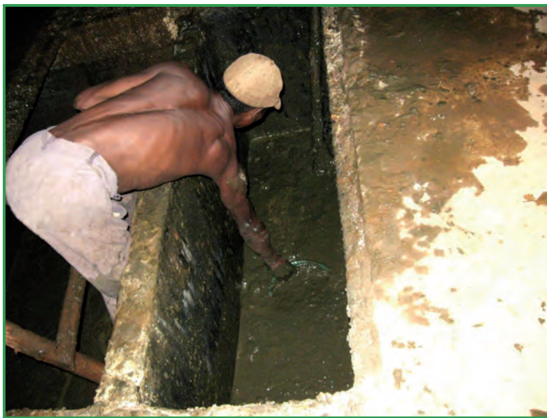
Figure 2 - Exemple de vidange manuelle [photo: H. Mavo Andriamaroandraina]
