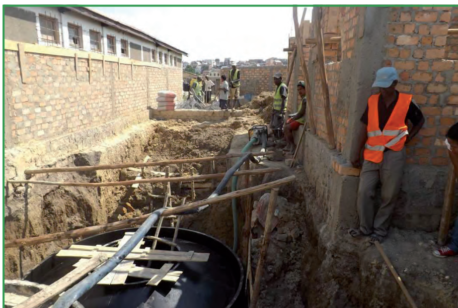
Figure 21 - Chantier de construction de la station d'Antanjombe
