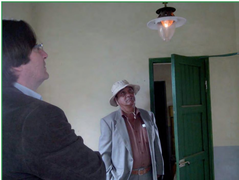
Figure 10 - Eclairage du local du gardien grâce au biogaz produit dans la station
