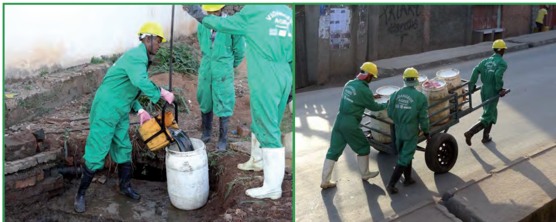
Figure 7 - Vidange de fosse et transport des boues
