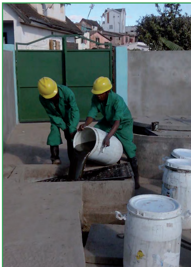
Figure 8 - Dépôt des boues de vidange dans la station de traitement
