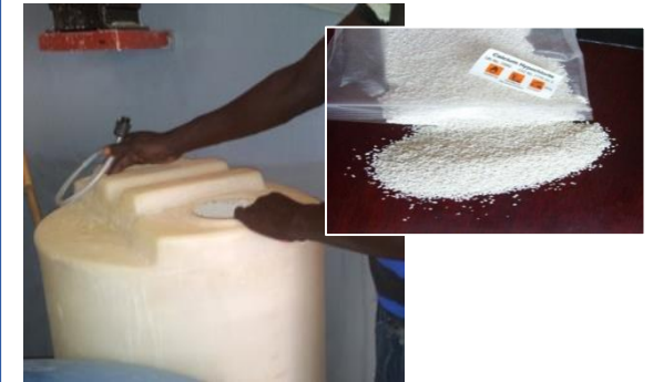
Cuve de solution mère de chlore
