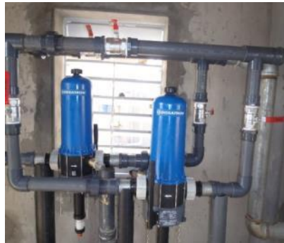
Pompe doseuse à entraînement mécanique (type Dosatron)
