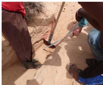
Contrôle de la profondeur des tuyaux au cours d'une visite
