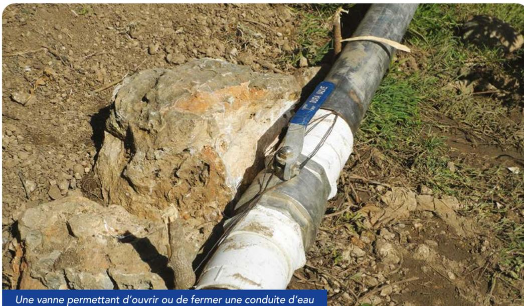
Une vanne permettant d’ouvrir ou de fermer une conduite d’eau
