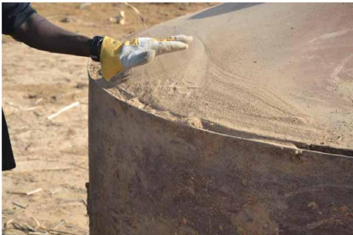
**8. Fermeture du couvercle et dépôt de terre pour l'étanchéité**
