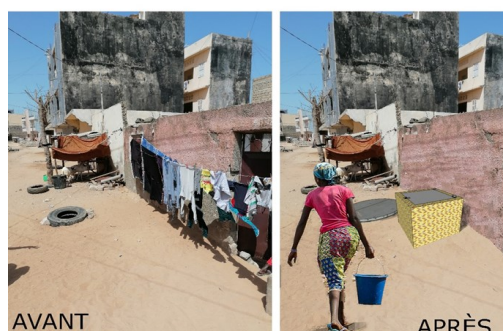
Ouvrage communautaire pilote : puisard
