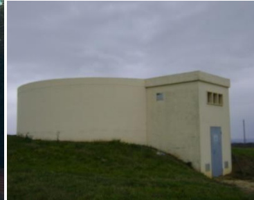
Réservoir sur sol
