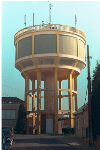
Réservoir sur tour
