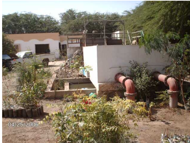
Station d'épuration de Nouakchott, source : cellule SPM/GRET/CUN
