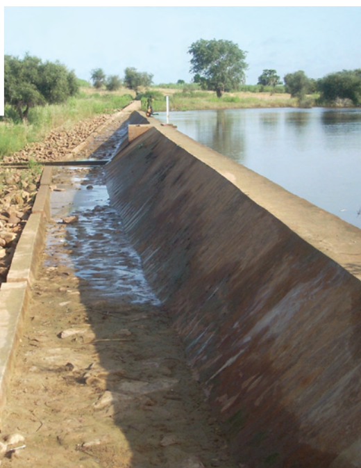
Exemple de bassin de dissipation
