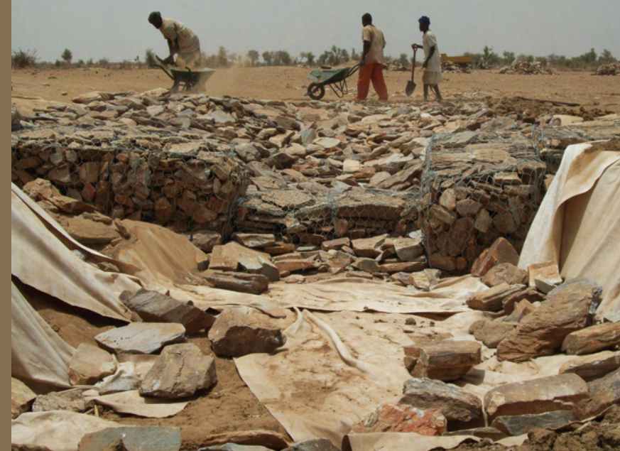
Traitement de ravines par la main d'œuvre locale (Guidimakha)
