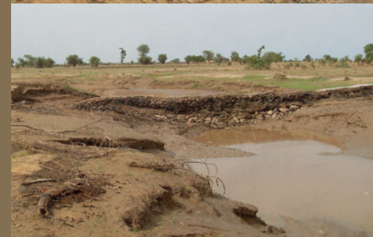
1) Seuil d'épandage de crues de Sedelme réalisé en gabions
