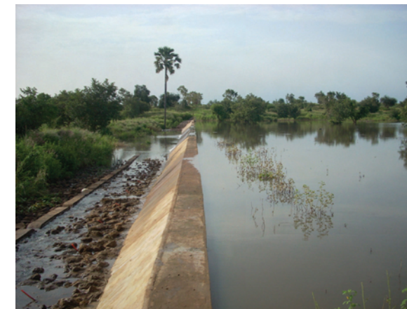
Observation des crues, de l'efficacité du bassin de dissipation, des éventuelles marques d'érosion régressive, des renardages, etc.
