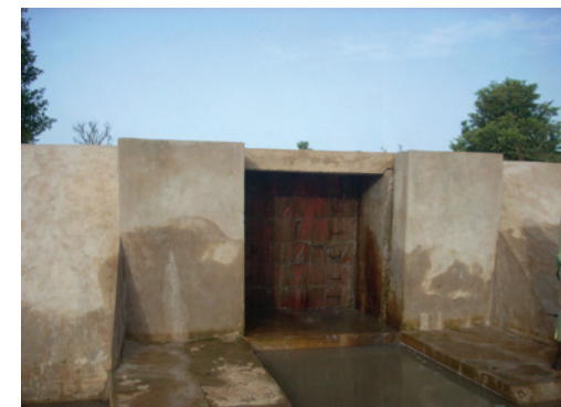
Les batardeaux ne sont jamais complètement étanches, une partie de l'eau s'écoule des interstices.
