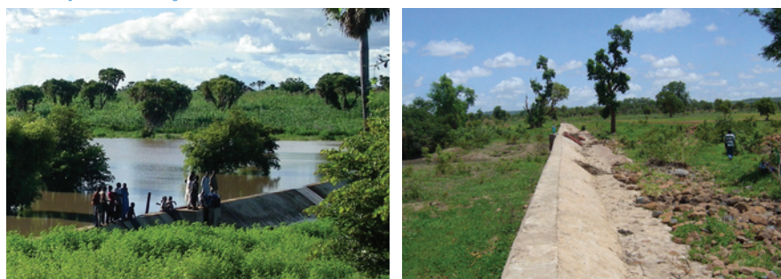
Seuils maçonnés de Koronga (commune de Sandaré) et de Seibath (commune de Koussané)
