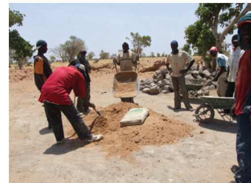
Mélange du ciment par la main d'œuvre villageoise
