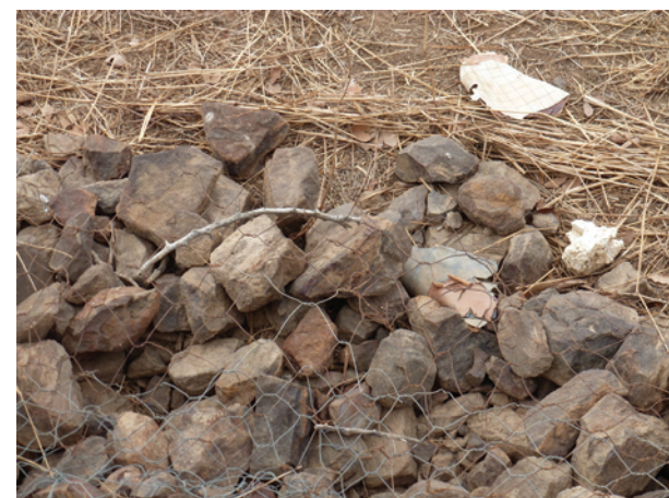
Exemple de dégradation de gabions causée par les animaux sauvages
