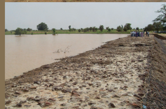
2) Une des 6 digues filtrantes du programme AGEPA (une des deux digues de Thiangol Madina). De longueurs variables (40, 60, 65, 100 (2 fois) et 130 m), ces digues sont faites de pierres libres sur les parties larges, et renforcées par des gabions au droit des ravins pour augmenter leur résistance à la poussée de l'eau.
