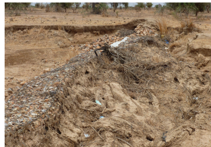
Embâcles coincés dans la digue filtrante du site de Medina Abdoul, zone de N'Gouronne
