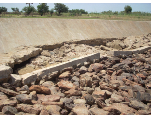
Dégradation du bassin de dissipation suite à un renardage – Site de Moussala, Commune de Koussané
