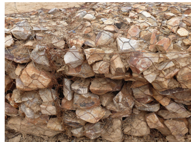
La présence de rouille entraîne un risque de rupture des gabions
