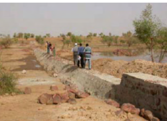
Finition du déversoir. Au premier plan mur latéral de protection
