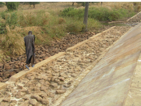
Bassin de dissipation, site de Séibath, commune de Koussané
