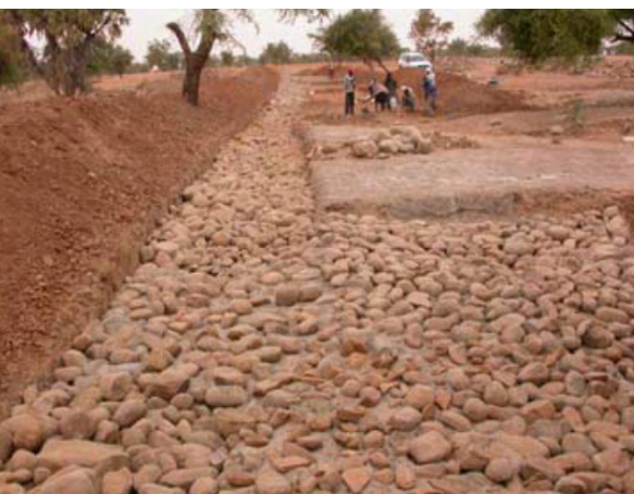
Blocage des fouilles et réalisation du bassin avant de commencer l'élévation du déversoir, Keleyla, Commune de Baidam, Mauritanie, février 2006
