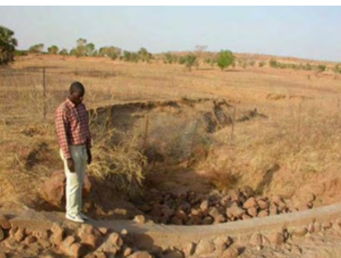
Creusement du lit en aval, menaçant le bassin de dissipation, Mesgoul, Mauritanie, 2008
