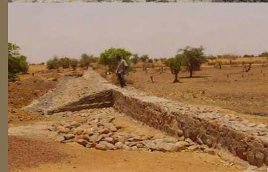
3) La digue déversante de Gourel Diallobé (zone de N'gouronne). Longue de 300 m, elle est composée : de digue en terre compactée, d'un déversoir en terre compactée recouverte de perré maçonné et d'un bassin de dissipation en enrochement recouvert de gabions en pente. La retenue d'eau couvre environ trois (3) hectares et tarit en avril, soit six (6) mois après l'hivernage.
