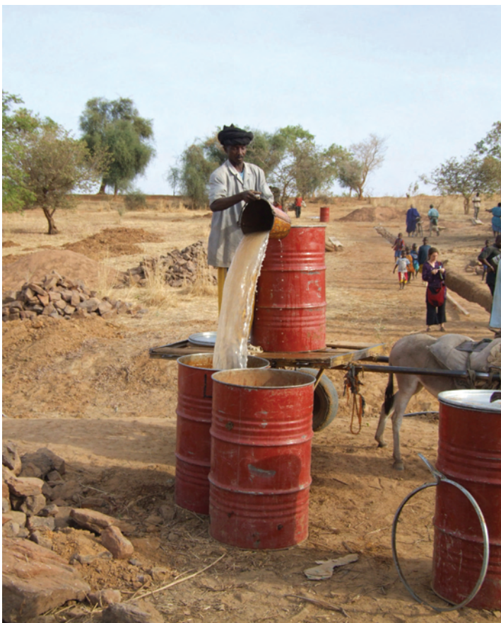
Approvisionnement en eau du site de Seibath, commune de Koussané
