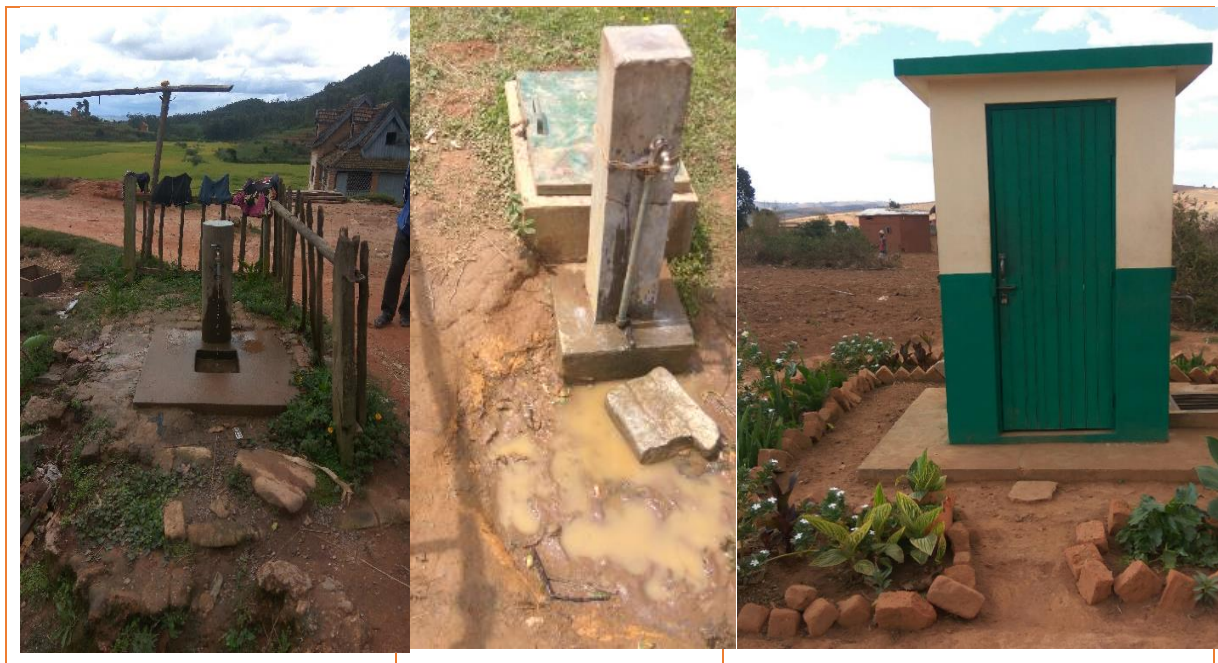
Photo 1: Etat des points d'eau
