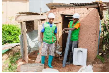
Ecodio : construction d'une toilette à Ankofafa Ambony
