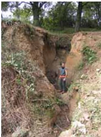
La Goutte des Verrières, Charbonnières (69)
