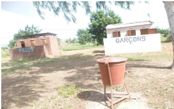
Image15 : Bloc de latrine séparés par sexe
