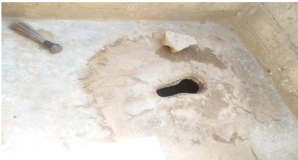
Image 2 : Vue intérieure d'une latrine Sanplat
