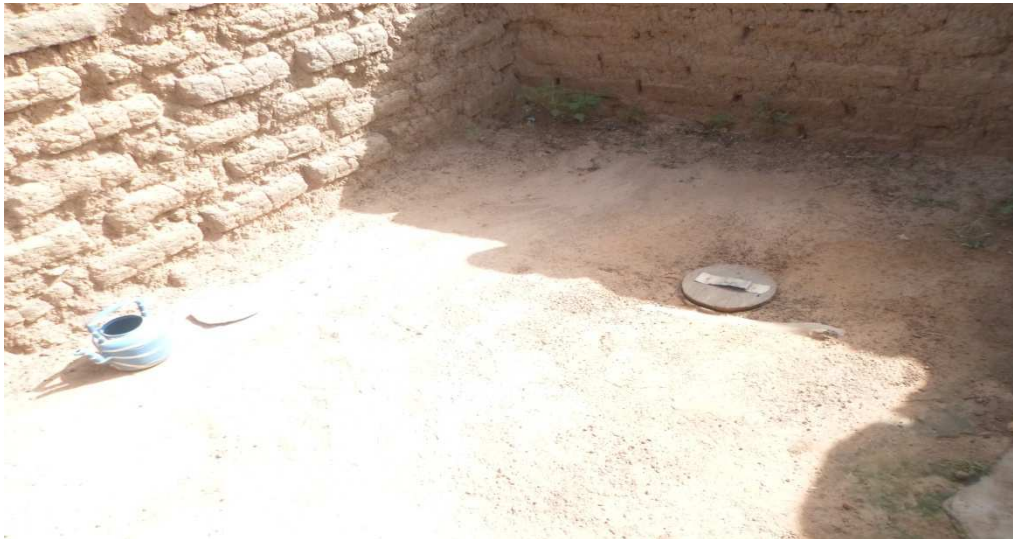
Image 3 : Vue intérieure d'une latrine traditionnelle
