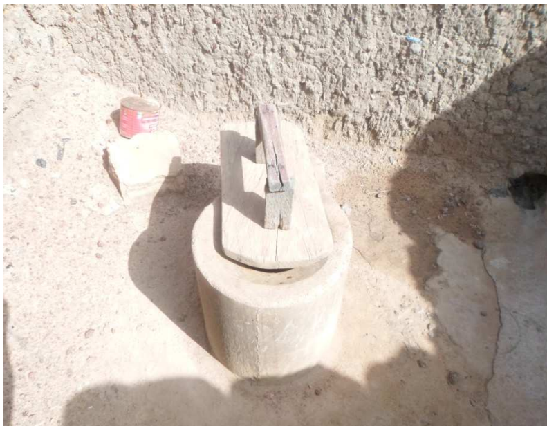
Image 11 : Latrine trou de défécation surélevé pour faciliter l'usage de personnes âgées
