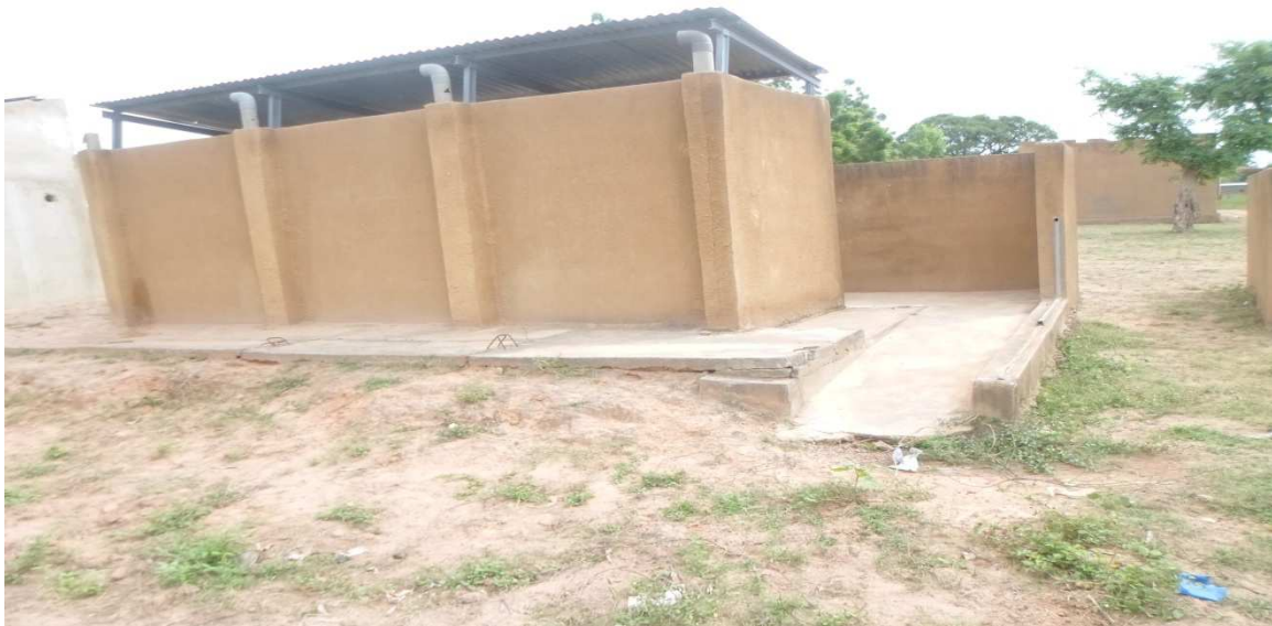
Image 12 : Latrine scolaire type VIP équipée d'une rampe d'accès pour handicapés
