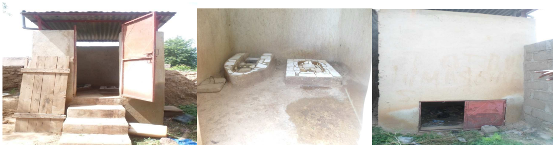
Image 1: vue de face et de l'intérieure et de l'arrière d'une latrines Ecosan
