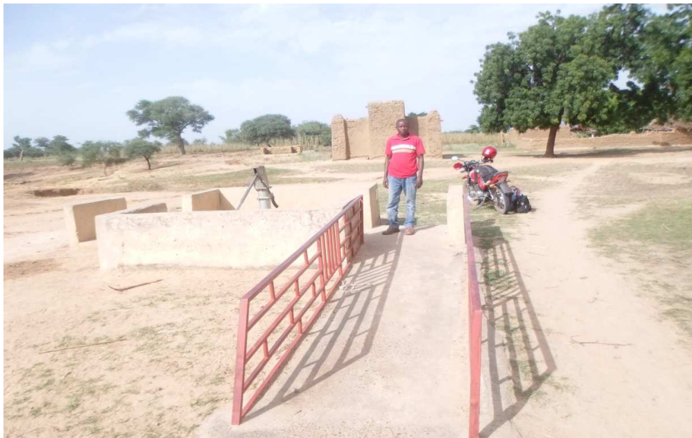
Image 21 : Clôture de PHM avec rampe d'accès pour handicapés
