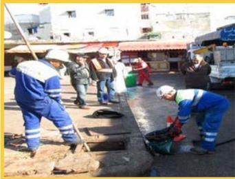
Le tringlage manuel ou mécanique : Le plus simple consiste à déplacer entre deux regards un appareil (curette, boule de curage, vrille ou hérisson) tiré ou poussé par des cannes ou des câbles mécaniques. Ces appareils sont manœuvrés à la main, au moyen d'une manivelle ou de treuils à main. Le travail est pénible et le rendement faible. Ce matériel trouve son utilisation pour tous les travaux de désengorgement des embranchements.
