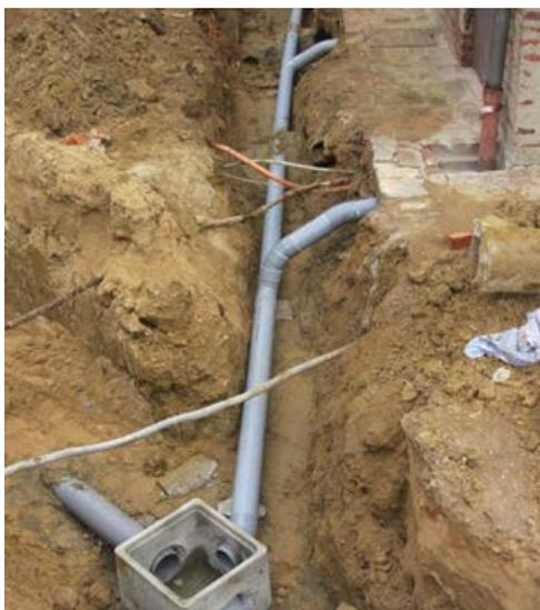
Avant l'assemblage des conduites, les abouts mâle et femelle sont nettoyés. Les conditions d'emboîtement doivent être conformes aux prescriptions du fabricant. Il convient d'utiliser les appareils et lubrifiants conseillés. Pour les éléments de regards et les boîtes de branchement, le jointoiment au mortier est proscrit,
