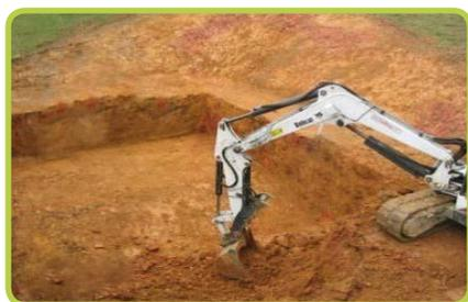
**Les fouilles en pleine masse** : sont exécutées sur la totalité de l'emprise des ouvrages afin d'en atteindre le niveau le plus bas (dans le cas d'un bassin par exemple).
