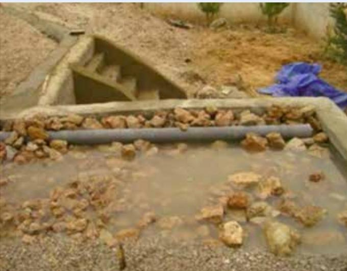
Image 41: Le bassin est mis sous eaux et la chambre de visit en sortie du filtre est également sous eaux. L'angle d'inclinaison du tuyau de sortie règle le niveau d'eau dans le bassin
