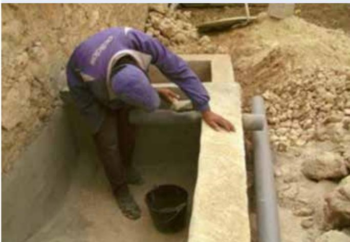
Image 25: Préparation du drain et du système de répartition
