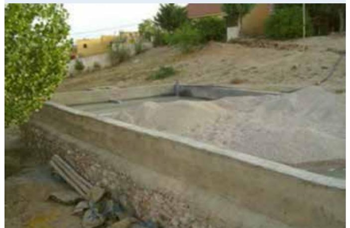
Image 32: Placement des gravier dans le bassin du filtre
