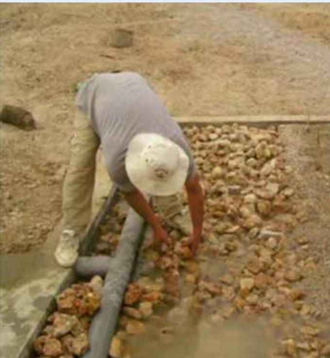
Image 40: Le tuyau de répartition est scrupuleusement ajusté à l'horizontale
