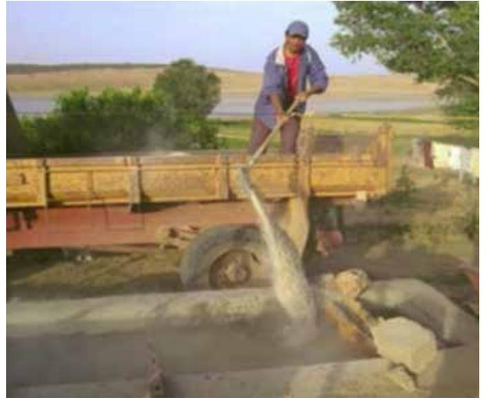
Image 30: Déversage du gravier dans le bassin du filtre
