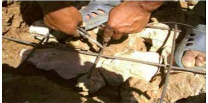
Image 10: Placement des fers à béton destiné au béton armé du radier du filtre planté
