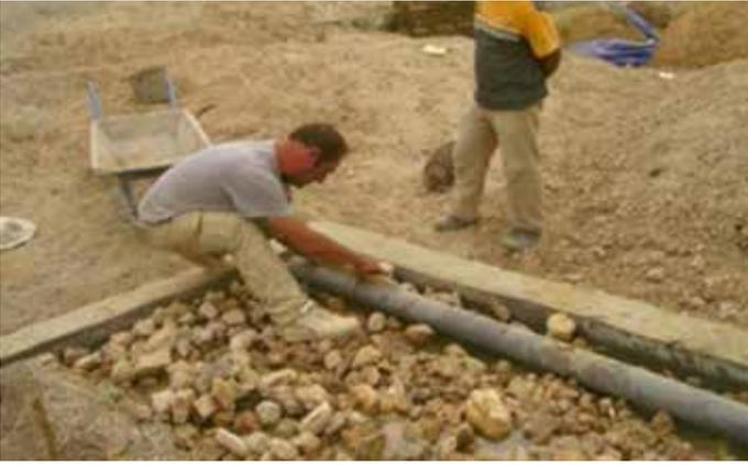
Image 39: Ajustement de la disposition des galets à l'entrée du bassin
