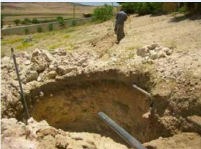
Image 3 - Le tuyau PVC est placé dans la tranchée et enrobé d'une couche de sable stabilisé au ciment
