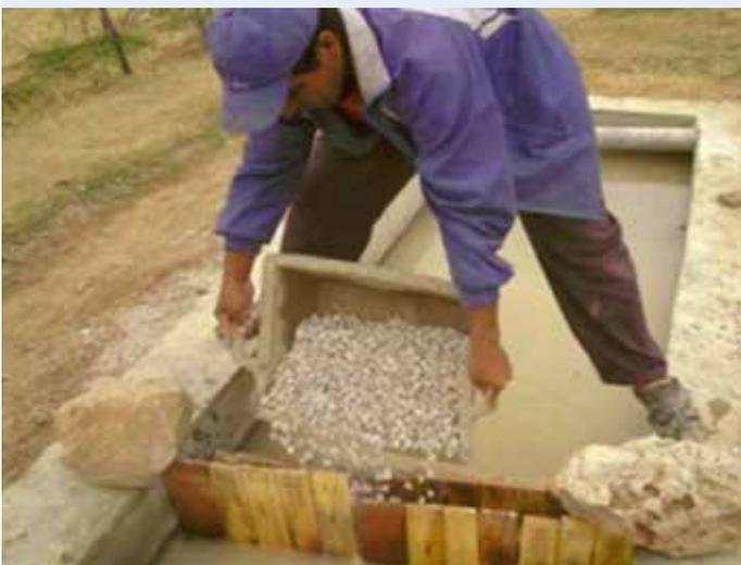
Figure 36 - Bassin du filtre avec trois couches verticales du filtre de graviers de granulométrie différente
