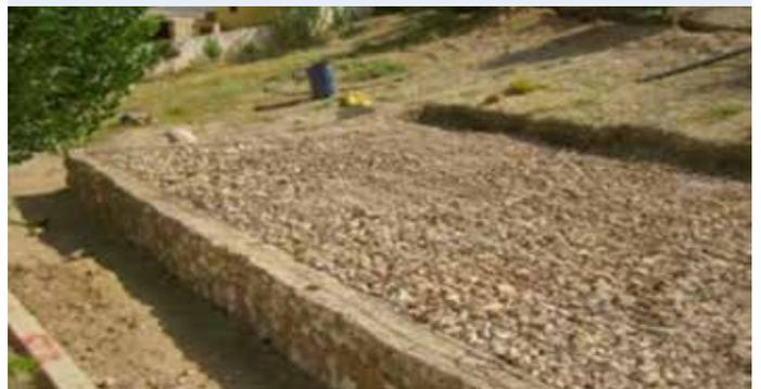
Image 12: Coulage du béton du radier (dalle de fond) directement sur les moellons
