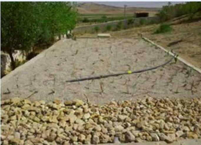
Image 46: Vue du filtre planté terminé nouvellement planté
