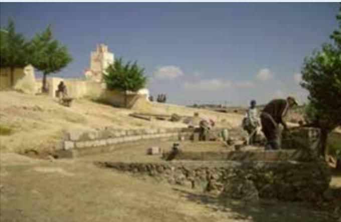
Image 15: Les parois du filtre sont montées à l'aide de parpaings en béton remplis de mortier
