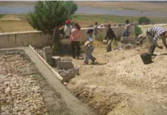
Image 16: Renforcement des angles des parois avec des fers béton de 8mm à chaque niveau de blocs
