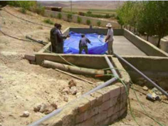
Image 27: Drain avant son placement dans le bassin
