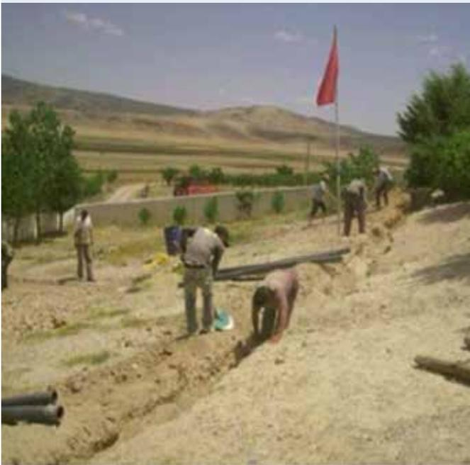
Image 2 - Arrivée des eaux usées au niveau de ce qui sera le système de traitement primaire (décanteur/digesteur)
