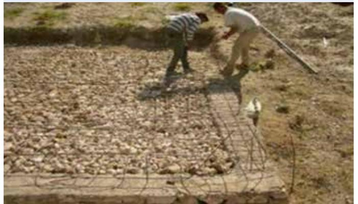
Image 11: Vue de la fondation avant de couler le béton de radier
