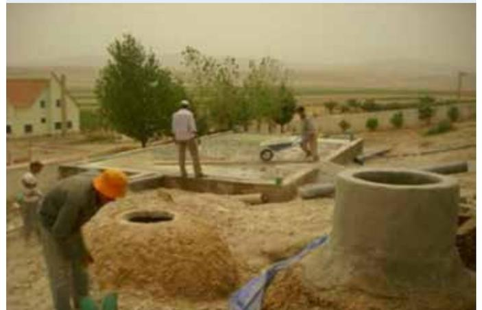
Image 31: Placement des graviers dans le bassin du filtre
