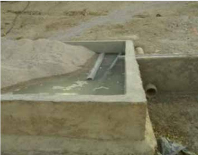
Figure 35 - Placement des graviers dans le bassin
