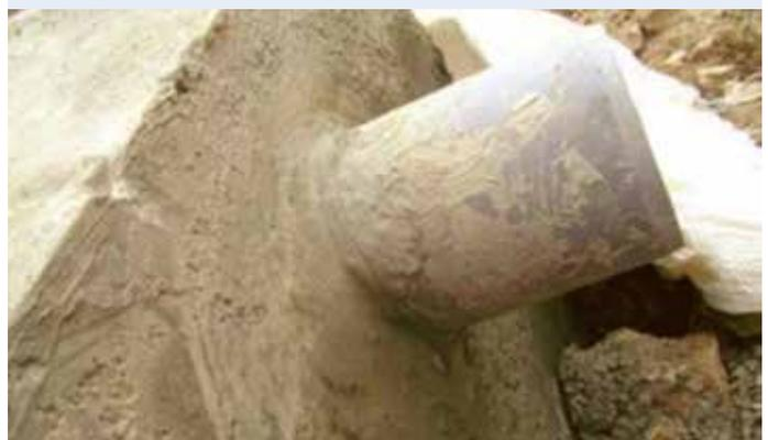
Image 20: Construction de la chambre de visite aval du filtre
