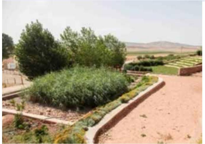
Image 45: Vue de filtre planté terminé nouvellement planté
