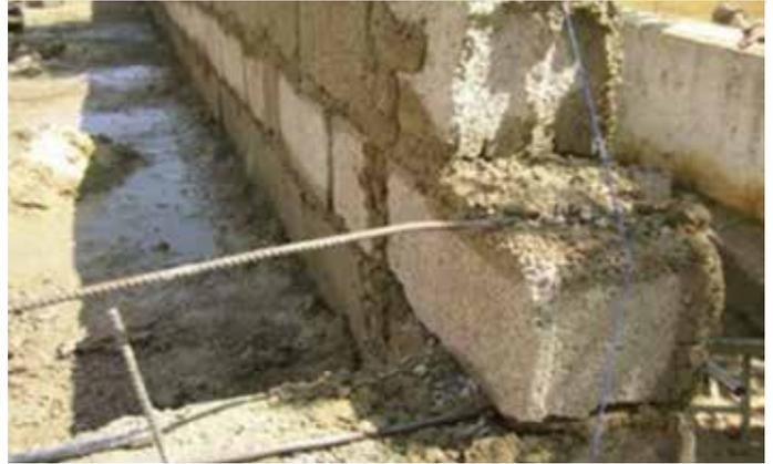
Image 17: Un enduit de finition à but esthétique est appliqué sur l'extérieur des parois du filtre
