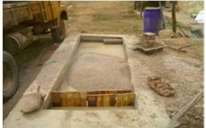
Image 33: Technique de répartition des différentes granulométries de gravier
