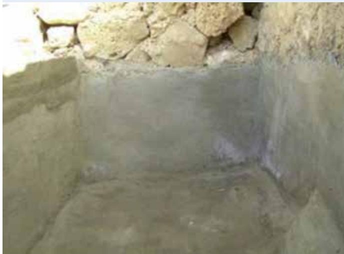
Image 21: Préparation de l'enduit imperméabilisant (lait de ciment avec un peu de Sikalite)
