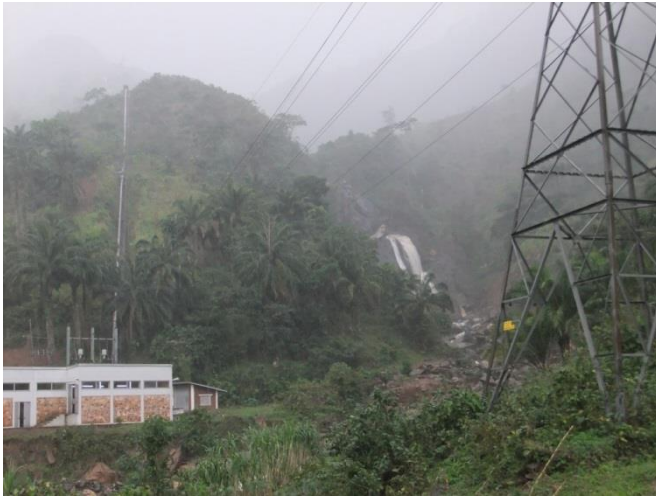
L'usine hydro-électrique de Nyemanga sur le Siguvyaye, affluent de la Murembwe
