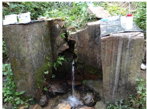
Source aménagée « rusengo » dans un état de dégradation avancée
