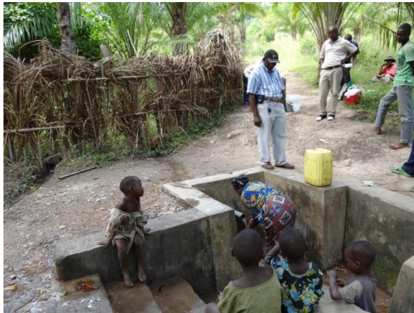
Le seul rusengo avec un périmètre de protection de captage clôturé, vu au cours de l'étude de base.
