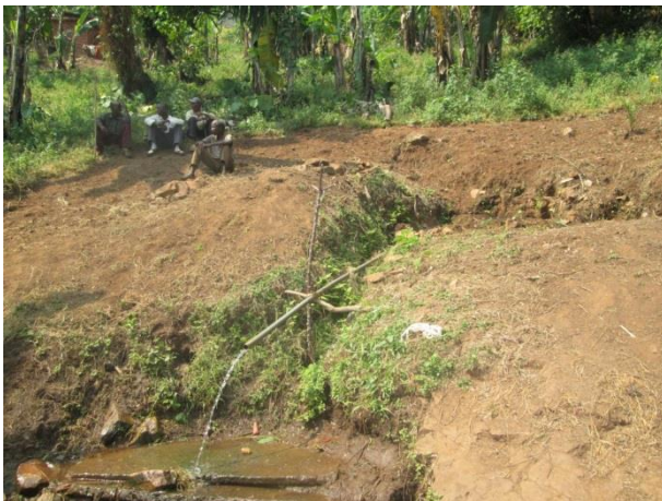
Source aménagée localement
