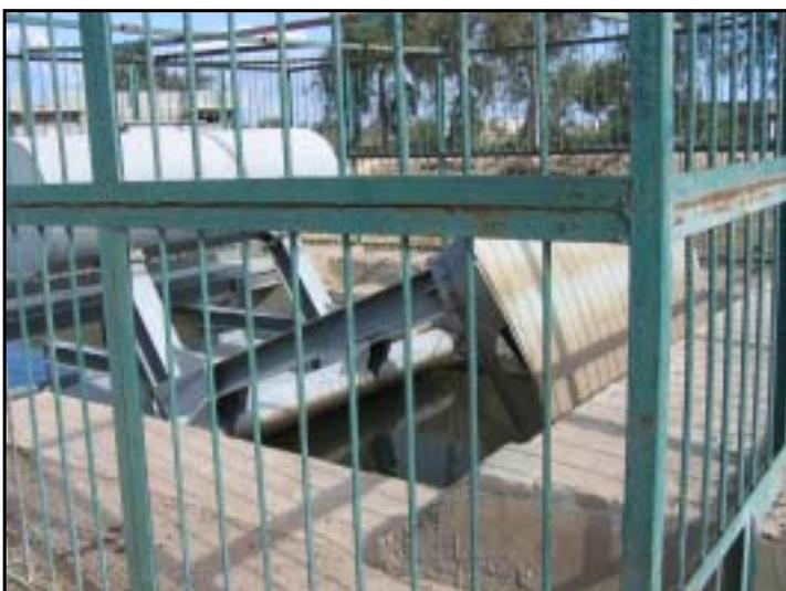
Photo 4 : les coussins flotteurs qui règlent le débit de l'eau en fonction du niveau de l'eau en aval.
