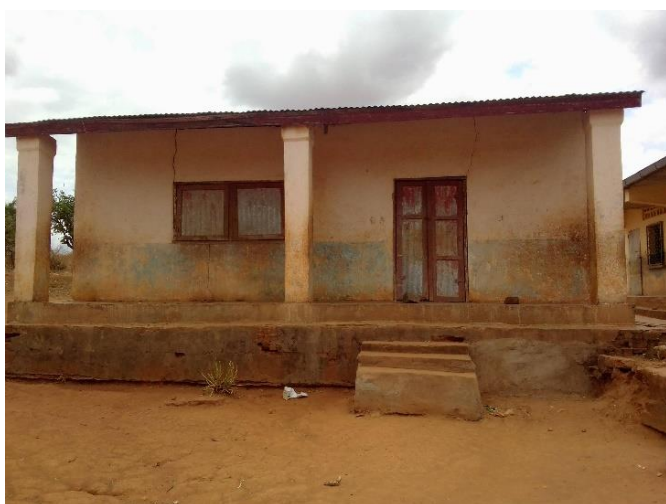
Le bâtiment de l'école primaire de Beanana avant et après réhabilitation. ©OPCI
