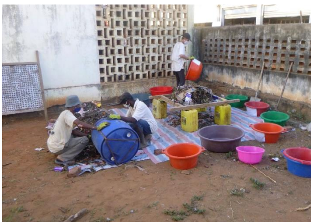
Caractérisation des déchets : opération de tamisage. © Gescod
