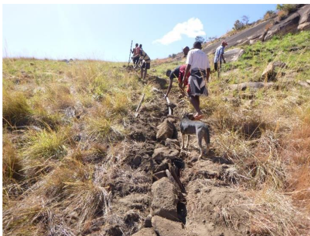
Sécurisation des tuyaux de conduite d'amenée. ©OPCI
