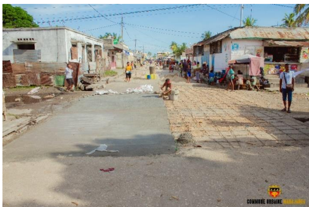
Réhabilitation d'un axe routier
