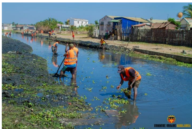
Curage HIMO du canal principal d'évacuation des eaux du Vallon Metzinger
