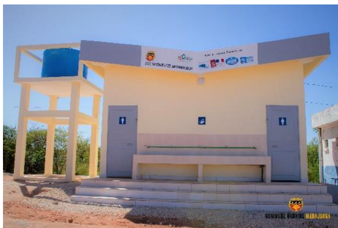
Bloc sanitaire au sein d'une école primaire publique.
