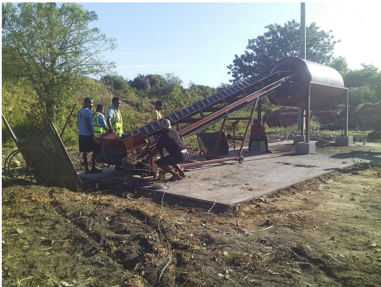
Le personnel du site effectue les tests de fonctionnement des équipements. © Gescod
