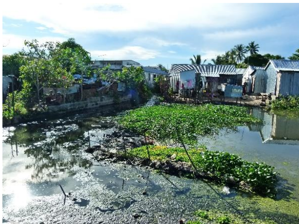
L'un des bassins tampons du Vallon, entièrement saturé d'eaux grises, d'eaux de pluie et de déchets. © Gescod
