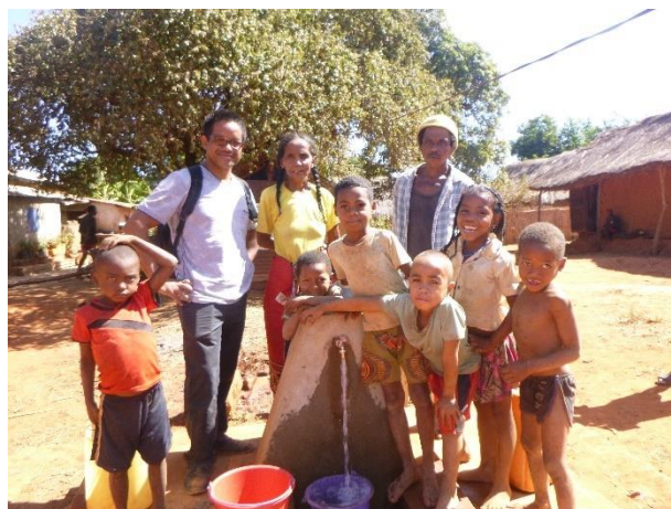
Ouverture officielle d'une des bornes fontaines du réseau. ©OPCI
