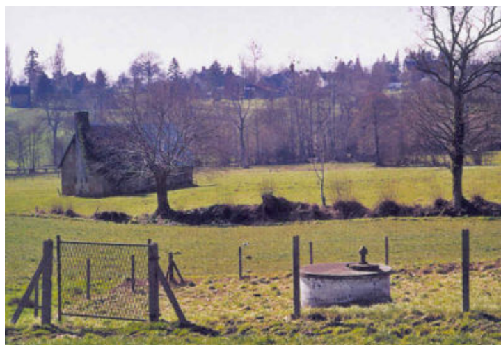
Captage de Sainteny
