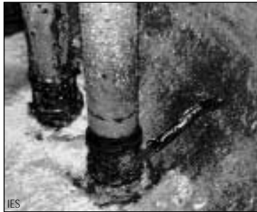
Photo 3 : La corrosion du tuyau est si importante qu'on peut le percer avec un couteau.
