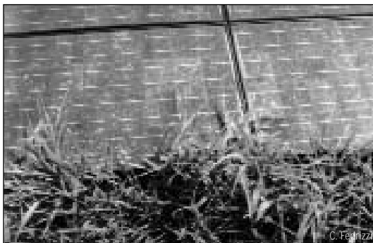
Figure 4 : L'herbe fait de l'ombre aux modules.
