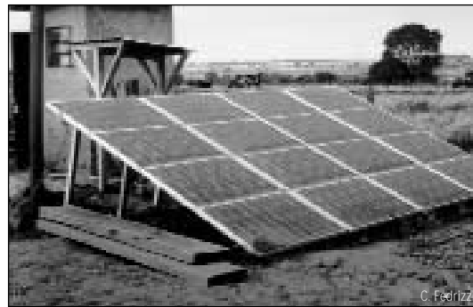
Figure 5 : Le positionnement au ras du sol favorise l'accumulation de poussière sur les modules.
