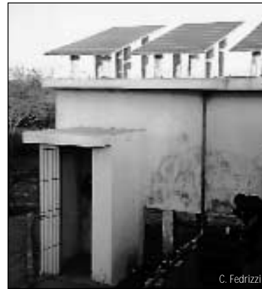
Photo 2 : Une filtration est disposée à l'extérieur du réservoir.
