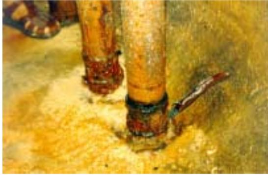
Figure 72. Corrosion des conduits avec fuite d'eau.
