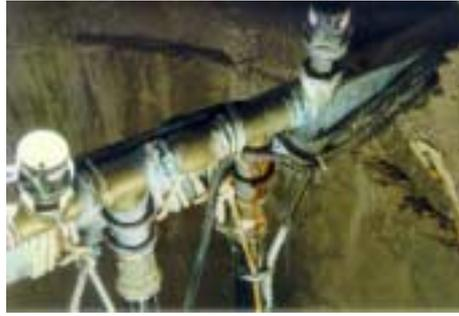
Figure 45. Fuite d'eau à Abdi. La coloration brune est due à la présence d'argile dans l'eau.
