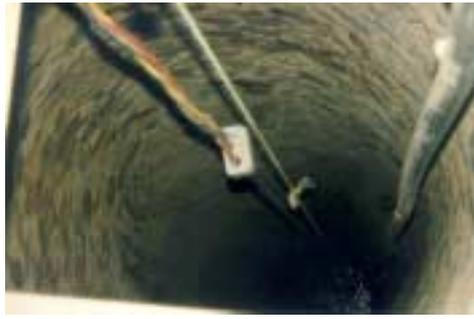
Figure 51. Branchements défectueux dans le puits d'Ourika.
