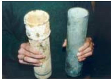
Figure 57. Ancien tuyau rouillé et tuyau neuf de substitution.
