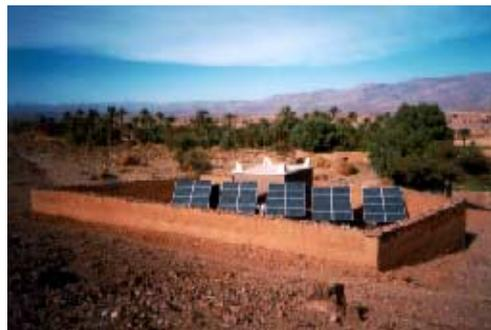
Figure 1. Système de pompage photovoltaïque type dans la vallée de Dra'a.
