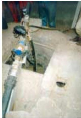
Figure 50. Fermeture inappropriée des puits facilitant la contamination de l'eau.
