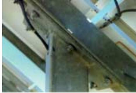
Figure 48. Rondelles oxydées dans la structure du générateur d'Albi.
