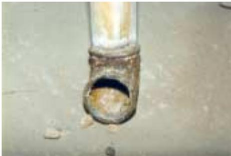
Figure 52. Conduit rouillé.
