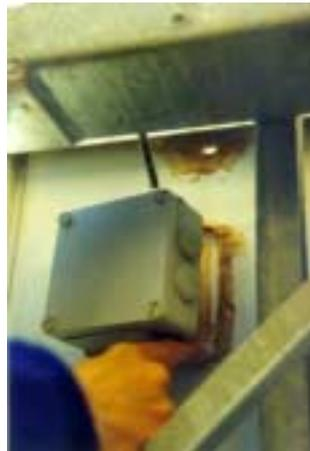
Figure 43. Boîtier décollé d'un module à Abdi.
