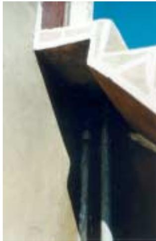
Figure 56. Perte d'eau due au débordement du réservoir causé par les fuites dans les conduits.
