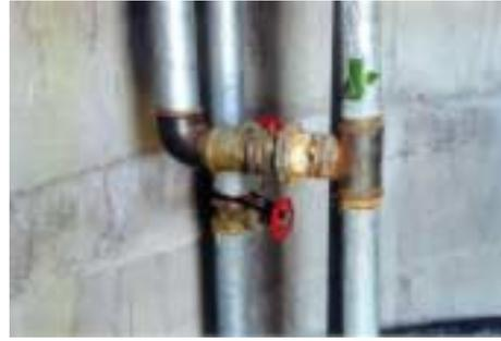
Figure 55. Pièces oxydées dans le conduit du réservoir d'Iferd.
