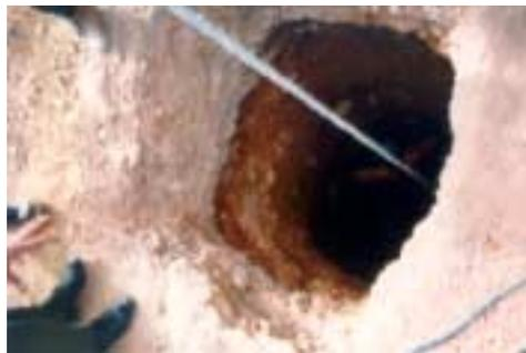
Figure 40. Construction d'une fosse septique comme celles utilisées traditionnellement dans la région. Les puits font en général 7 mètres de profondeur.
