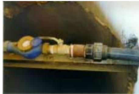
Figure 53. Pièces oxydées à la sortie de la pompe de Oum Erromane.
