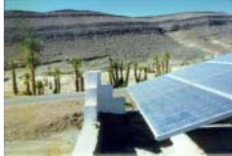
Figure 62. Manque de propreté sur les modules de Ouaougloute.
