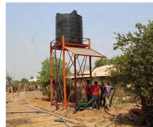
Installation d'un réseau de goutte à goutte avec château d'eau relié à une pompe solaire au Sénégal.
