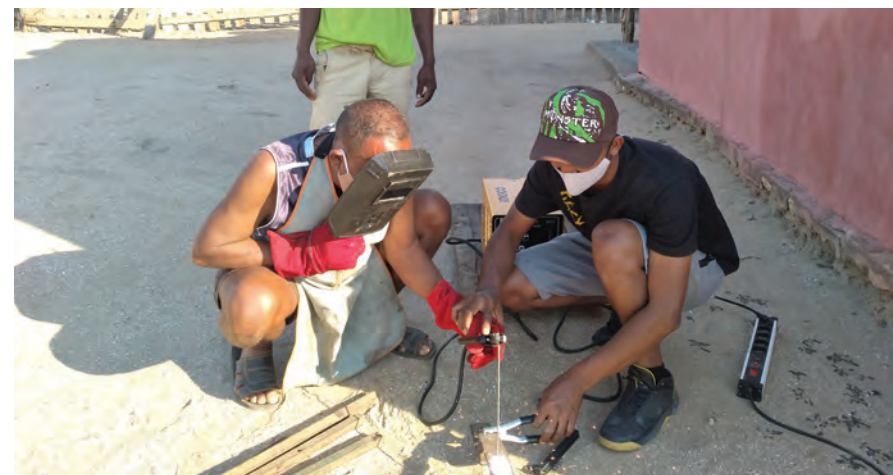
Porteur de projet malgache pratiquant sa nouvelle activité de soudure
