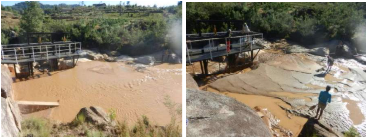
Photo 3: Ensablement du barrage de Fandriana
