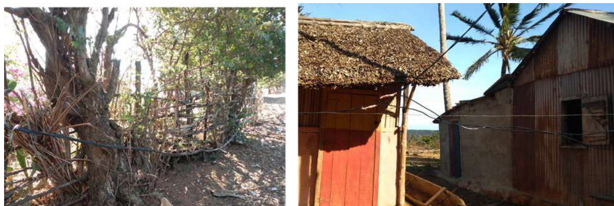
Photo 2: Réseau de distribution à Ambolobozokely (Mad'Eole)
