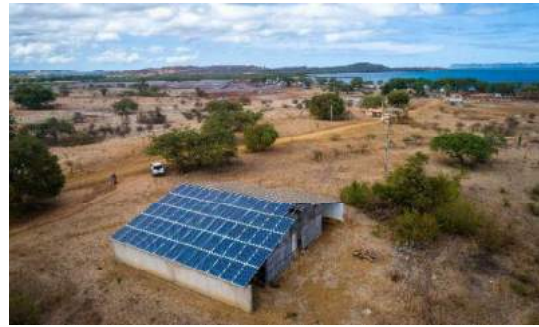
Photo 1: Centrale photovoltaïque d'Ampasindava -- ANKA Madagascar
