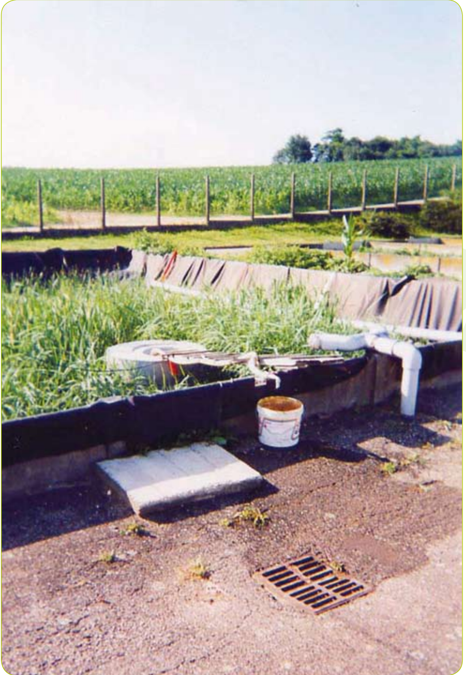
► Installation de filtres plantés dans le Bas-Rhin
