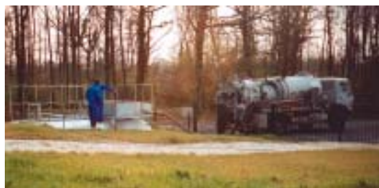
Photo 2 – Dépotage de matières de vidange à Beaumont-la-Ronce
