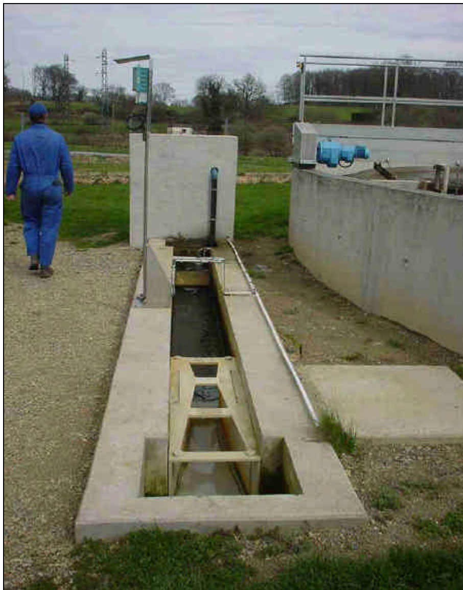
Photo 7 : Canal de mesure type Venturi
