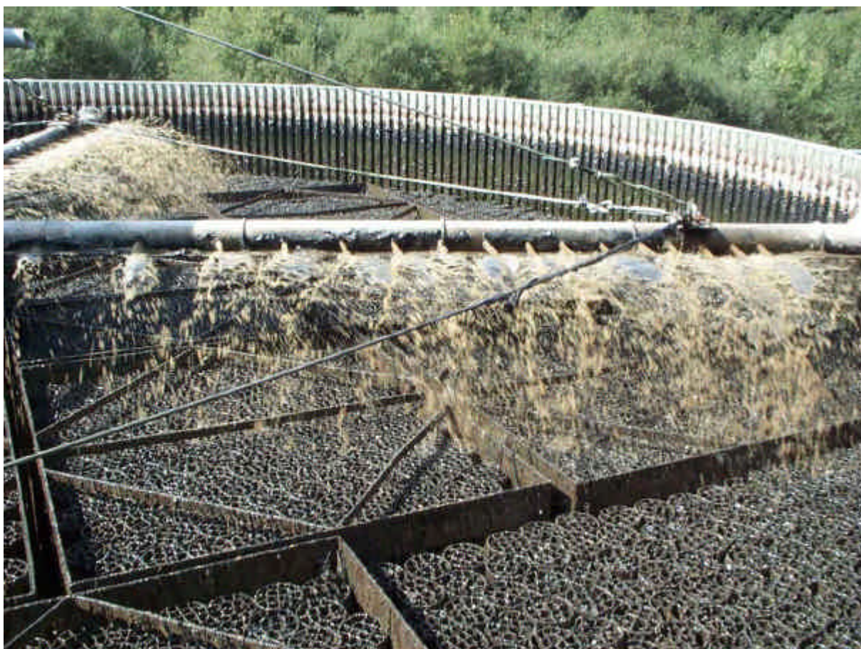
Photo 26 : Alimentation du lit bactérien (garnissage plastique)
