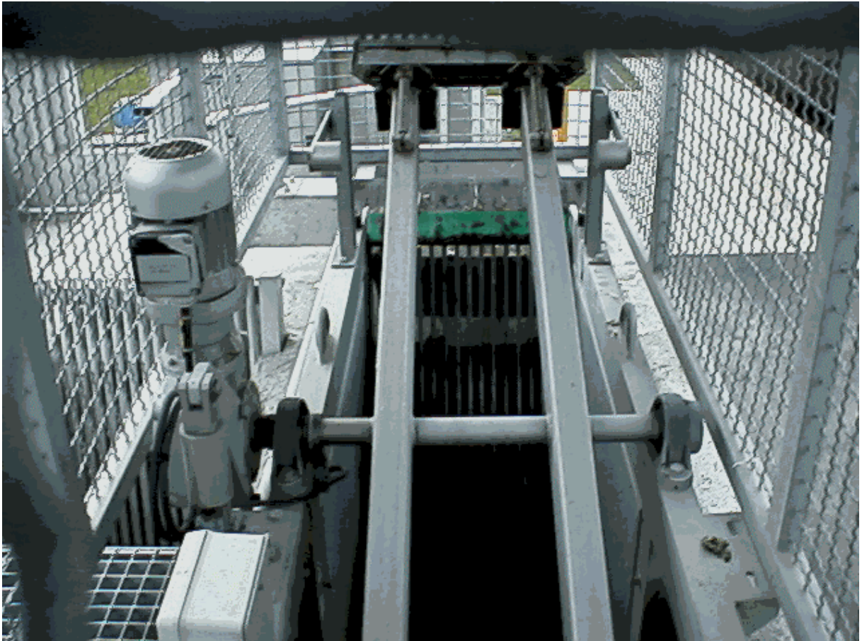
Photo 2 : Dégrilleur courbe
