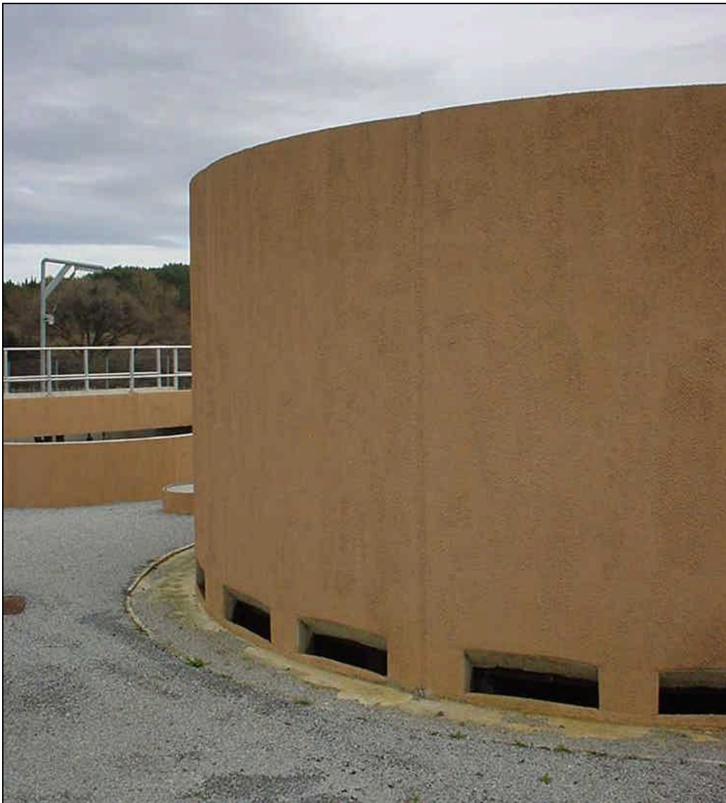
Photo 27 : Ouies d'aération du lit bactérien
