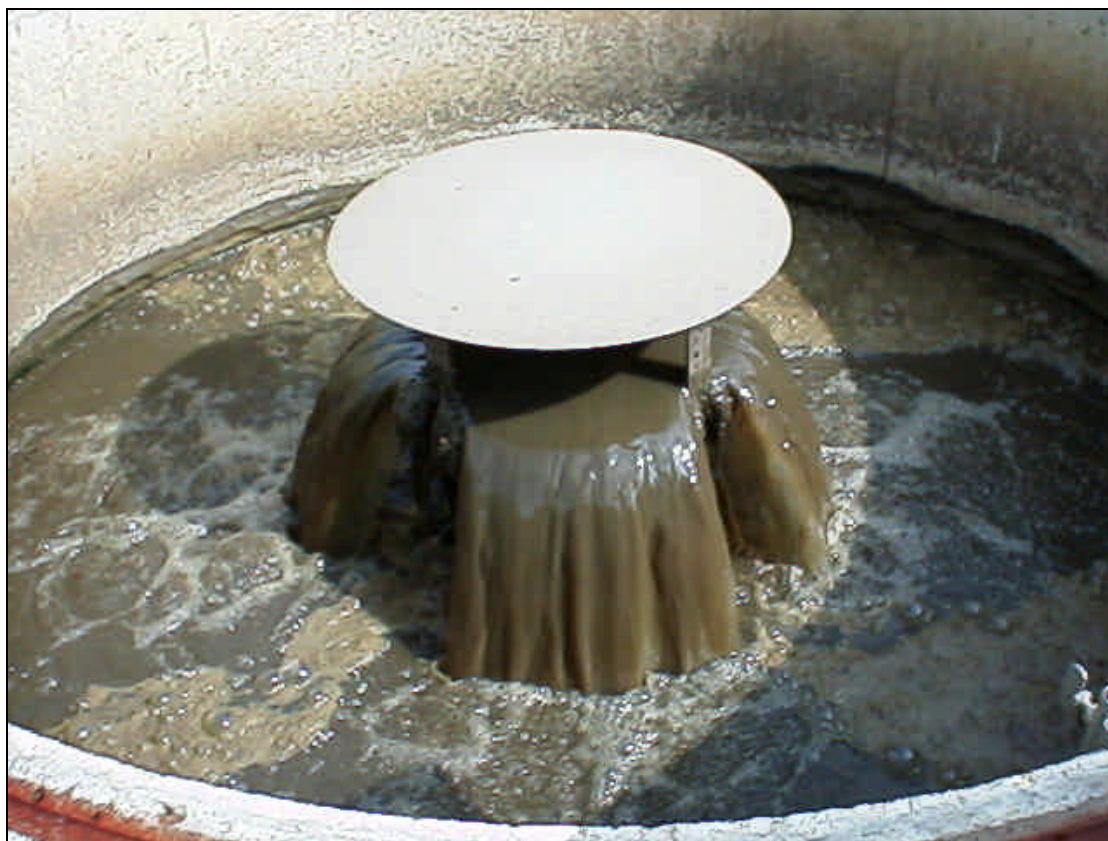
Photo 12 : ouvrage de dégazage
