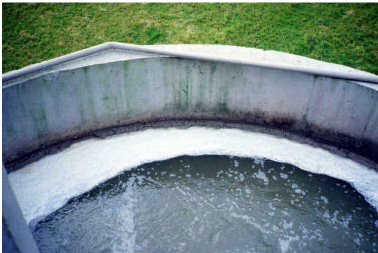
Photo 4 : Flottation des graisses par injection de fines bulles
