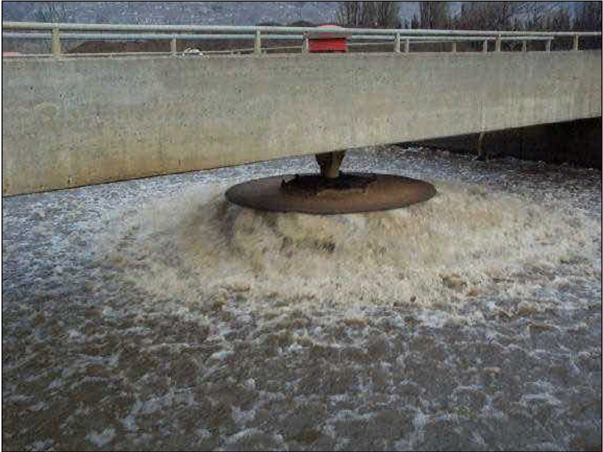
Photo 9 : Turbine de surface à vitesse lente (immersion insuffisante)
