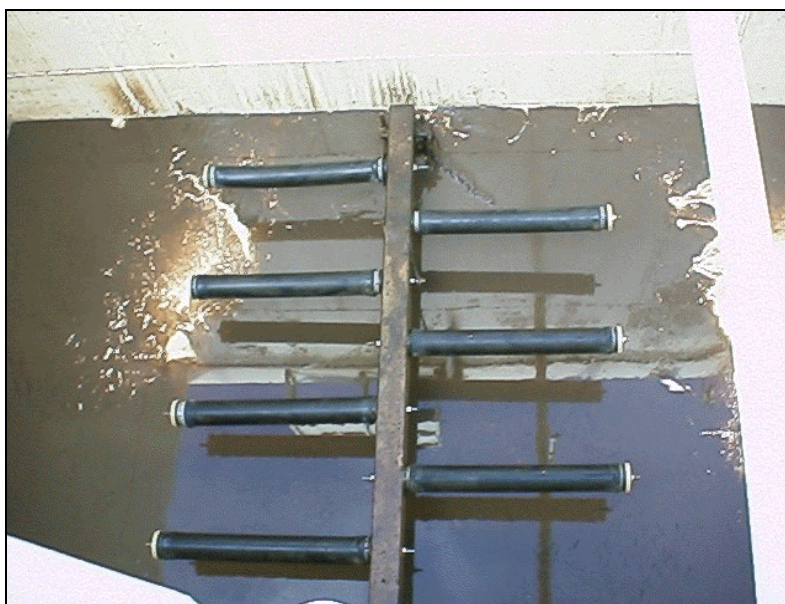
Photo 10 : Rampes immergées de diffuseurs fines bulles
