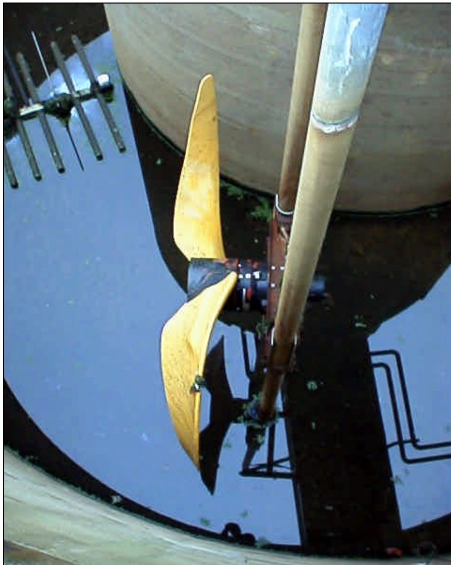
Photo 11 : Aération et brassage séparées dans un bassin d'aération
