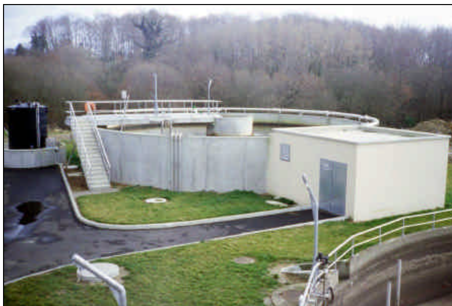
Photo 1 : Ouvrage hors sol équipé d'escalier muni de garde-corps
