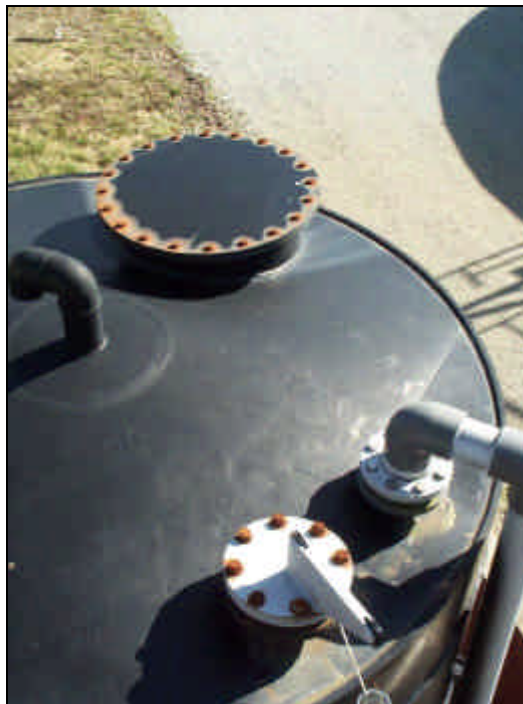
Photo 13 : Cuve de stockage du chlorure ferrique
