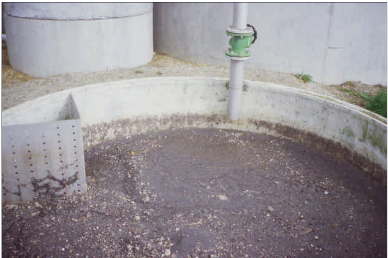
Photo 5 : Extraction du sable d'un dessableur-dégraisseur
