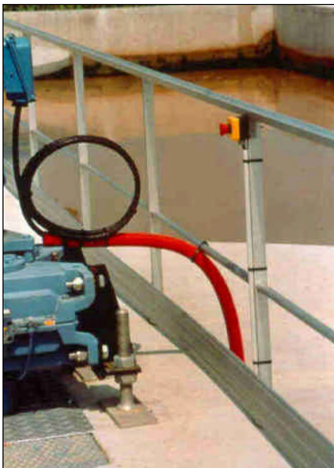
Photo 12 : Bouton d'arrêt d'urgence à proximité de la turbine de surface
