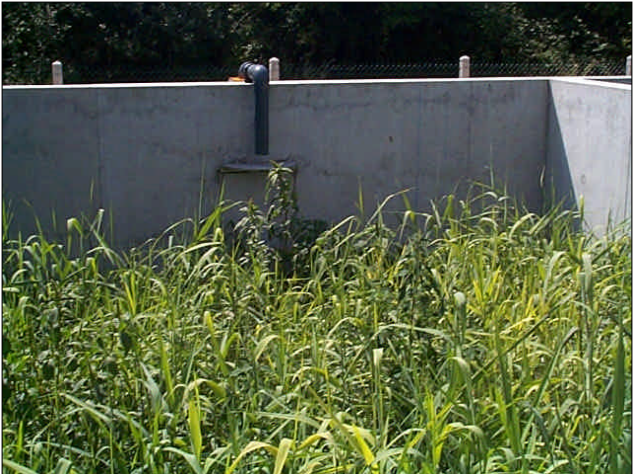
Photo 22 : lit de séchage planté de roseaux
