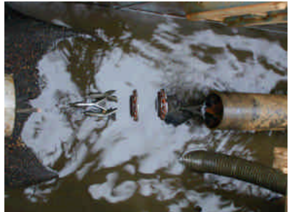
Photographie n°7. Raclage mécanique : le nettoyage 3R (source AXEO)
