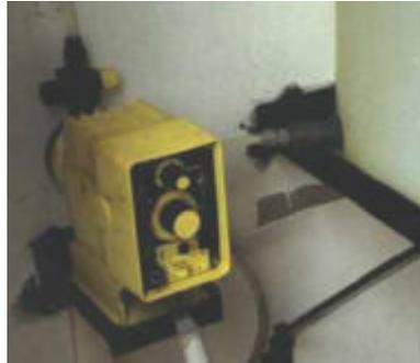
*Photo 3 – Pompe doseuse de chlore – Farinole (2A) – Réalisation SOLECO*
