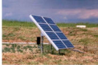
*Photo 1 – Alimentation du poste de relevage d'une station d'épuration – Ouzouer le Marche (41) – Réalisation VERGNET*
