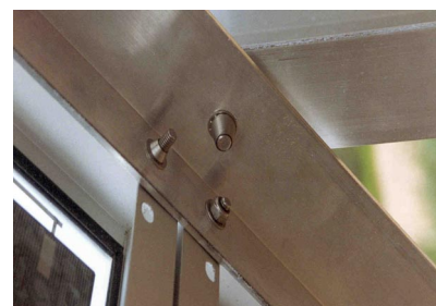
Figure 7 – Exemple de visserie antivol
