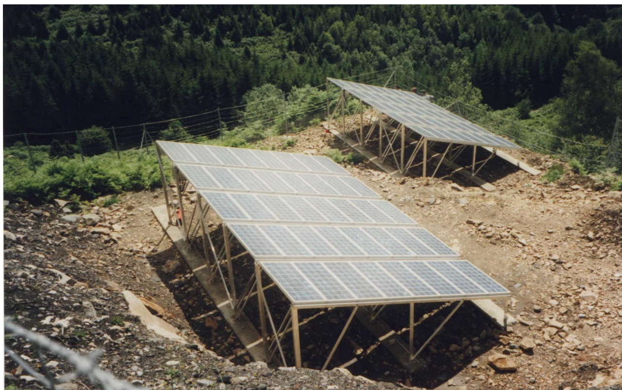
Figure 12 – Alimentation d'une installation de pompage – Estive de Bergons (Hautes Pyrénées) – Photo APEX – BP SOLAR
