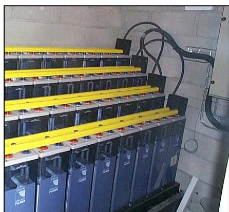
Photo 3 - Local batteries pour une aération de lagunes à Méze (34) - 1 220 [Ah] Photo APEX
