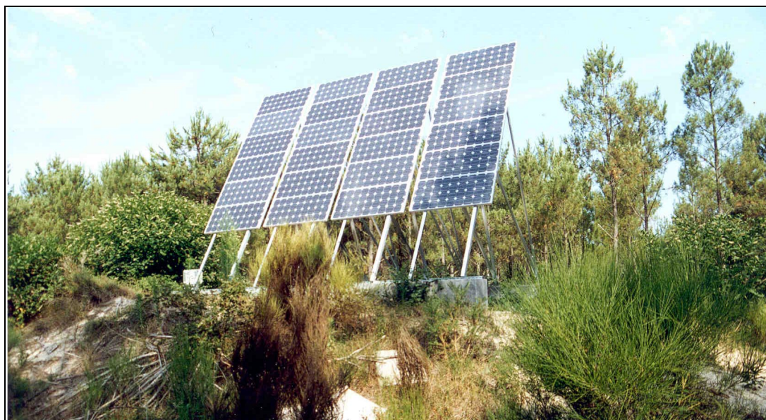
Photo 1 – Modules photovoltaïques – Alimentation d'électrovannes pour le Syndicat Intercommunal du Bassin d'Arcachon – Photo ADEME
