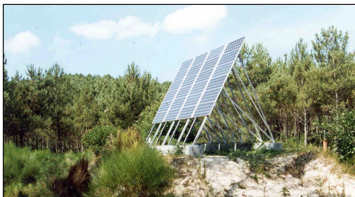
Figure 15 – Générateur photovoltaïque du SIBA – Photo ADEME
