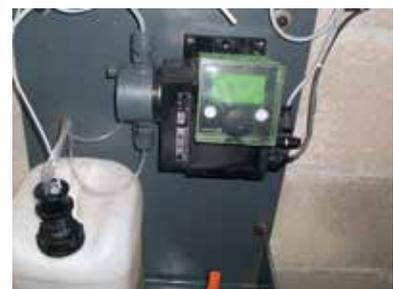
Injection d'une solution de javel par pompe doseuse
