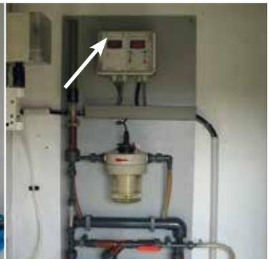
Injection de chlore, de solution d'hypochlorite dans l'eau à traiter, en s'assurant d'une concentration de 0,5 mg/l de chlore libre durant 30 minutes de contact. Selon les conditions de température, pH et qualité de l'eau à traiter, cette concentration peut être supérieure ou inférieure.
