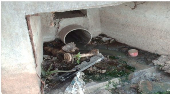
Image 9 : Exutoire débouchant sur la lagune
