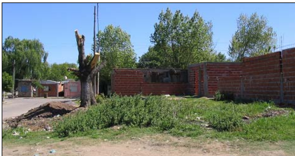
Construction de maisons en dur suite à l'obtention des titres de propriété foncière dans le quartier de la Villa Besada à Buenos Aires (Argentine).
