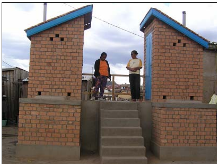
Contrôle de la propreté des latrines par un membre d’HI en présence d’une des propriétaires à Antananarivo (Madagascar).
