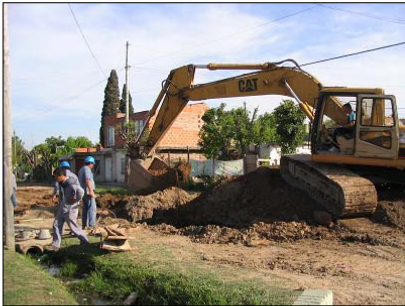
Construction d'une infrastructure pour le programme PROMEBA dans le quartier de Santa Elena à Buenos Aires (Argentine).
