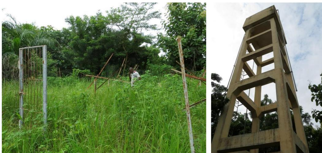
Le site des panneaux est à côté du forage et à côté du château d'eau, dans un endroit extrêmement isolé. Sans un autre château d'eau ce n'est pas la peine de rénover ce site. Le site ne peut être qualifié pour un simple remplacement par système solaire.
