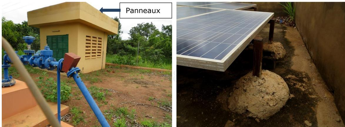
Les 7 mètres carrés de panneaux sont le maximum pour le toit de l'abri. Ils représentent 7 x 180 = 1260 Wc, qui est presque le maximum pour ce type de pompe.
