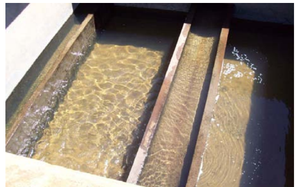
Fig. 11 – Filtres à sable (Photo : Moira RASIKA)
