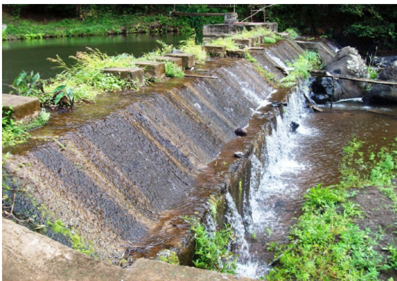
Fig. 7 – Barrage sur la Besokatra avec, sur la rive gauche, la prise pour la nouvelle conduite (Photo : Moira RASIKA)
