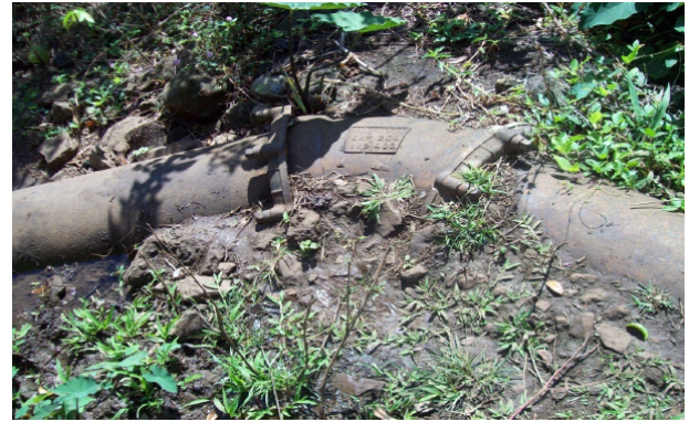
Fig. 9 – Ancienne conduite (1961) sur la rive gauche (Photo : Moira RASIKA)
