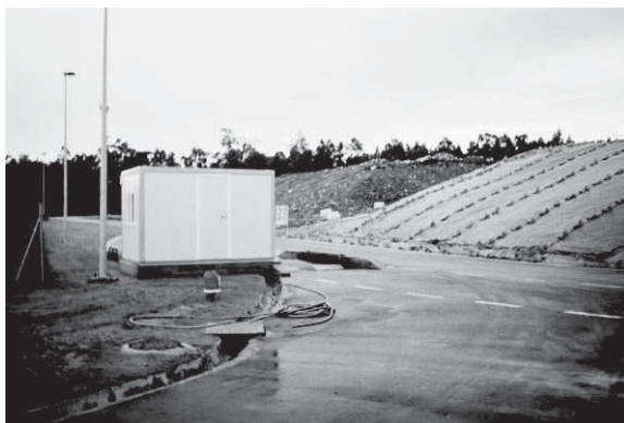
Figura 60 – Exemplo de colocação de telas temporárias (Ambirumo)
