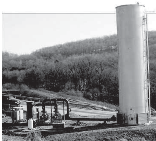
Figura 64 – Queimador de biogás (Ambirumo)
