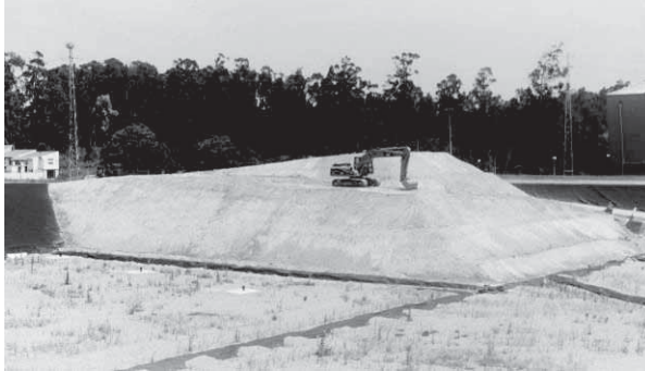
Figura 57 – Sistema de babetes instalado num aterro (Ambirumo)
