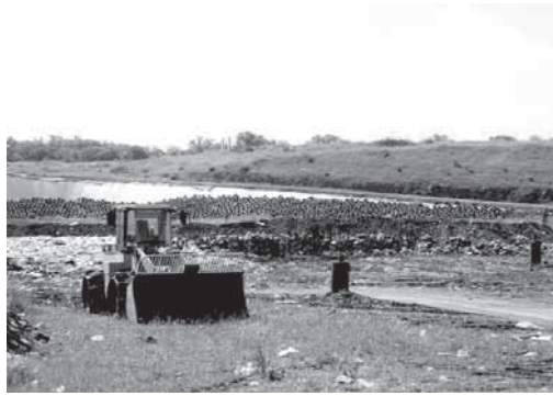
Figura 62 – Poço de biogás na fase de exploração (Ambirumo)
