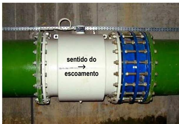
Figura 8.3 – Caudalímetro electromagnético de um sistema de abastecimento de água: junta de desmontagem imediatamente a jusante do primário (localização incorrecta)
