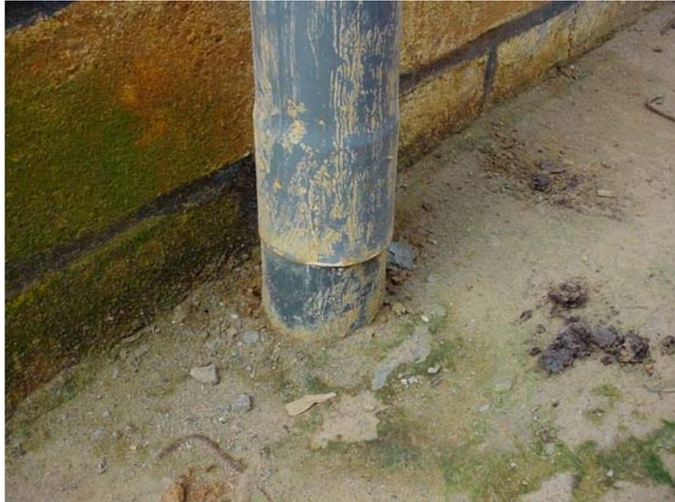
Figure 15 : emboîtement des tuyaux de ventilation
