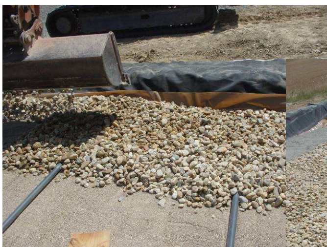
Photo 26 : Enrobage du système de distribution dans le gravier grossier
