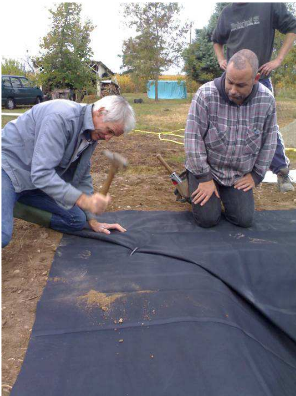
Photo 13 : Fixation de la géomembrane avec les agrafes
