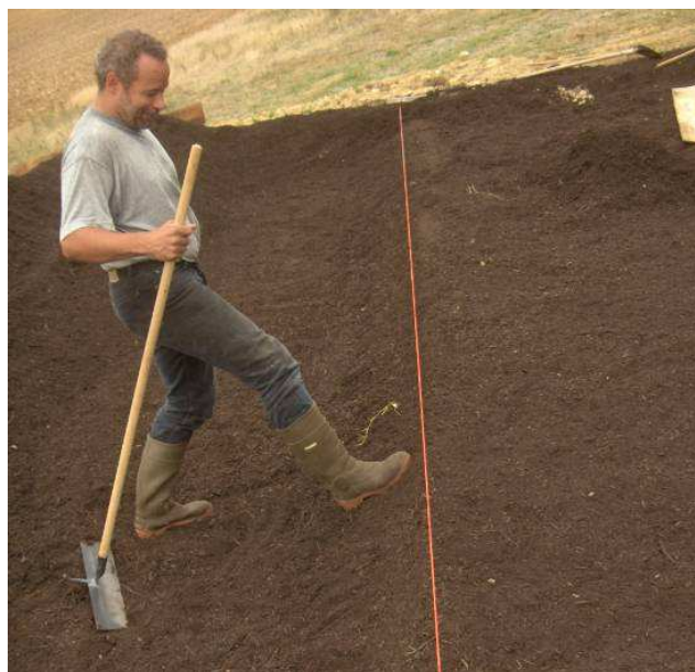
Photo 29 : mise en place du compost végétal (2)
