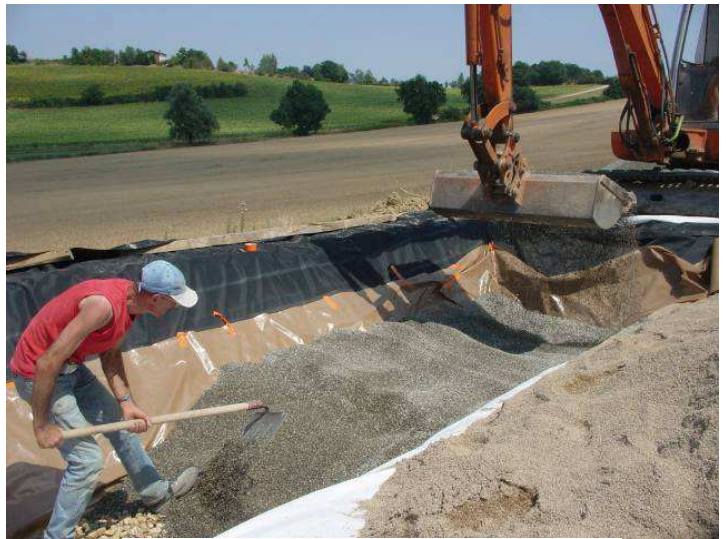
Photo 21 : Remplissage en gravier du compartiment horizontal (1)
