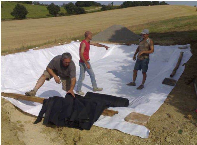
Photo 8 : mise en place de la bâche étanche en EPDM (1)
