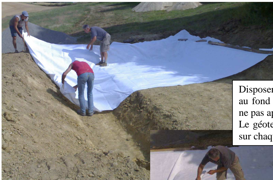
Photo 3 : Application du géotextile et recouvrement des lés (1)
