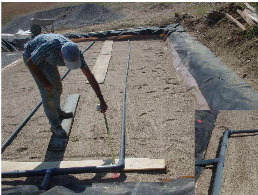
Photo 24: Pose du système de distribution à la surface du sable
