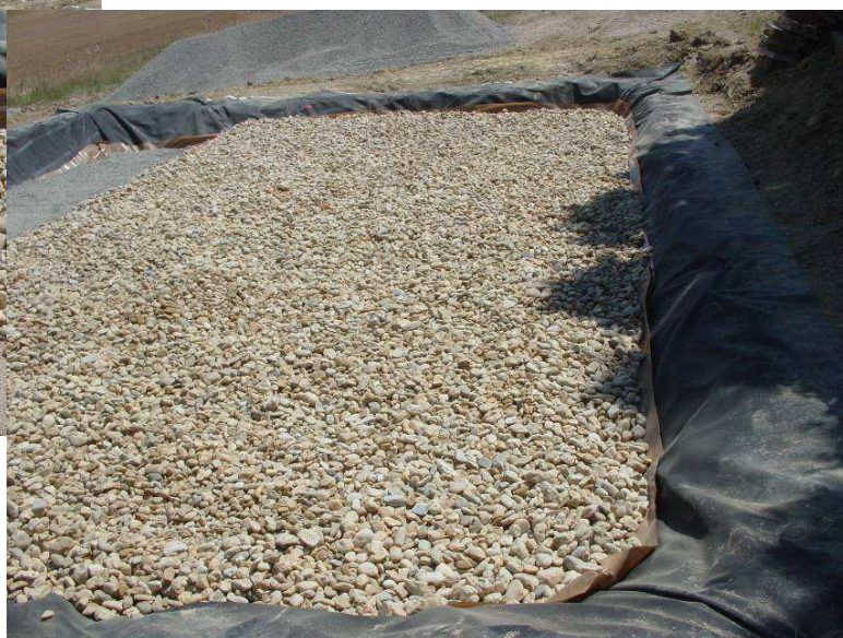
Photo 27 : vue du filtre avec couche d'enrobage en place
