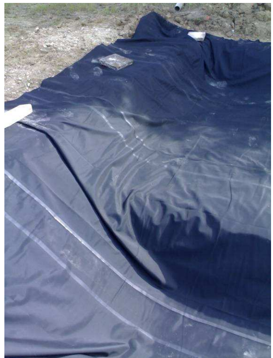
Photo 11 : application de la bâche étanche en EPDM dans les angles (2)
