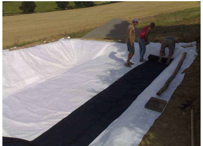
Photo 7 : mise en place de la bâche étanche en EPDM (2)
