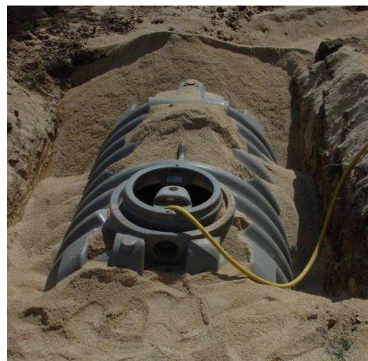
Photo 30 : Fosse toutes eaux en cours de remblayage
