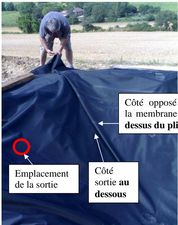
Photo 12 : application de la bâche étanche en EPDM dans les angles (1)
