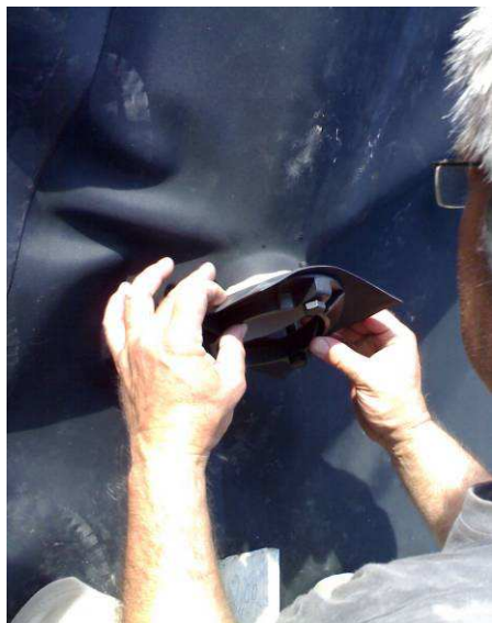
Photo 18 : Pose de la collerette d'étanchéité
