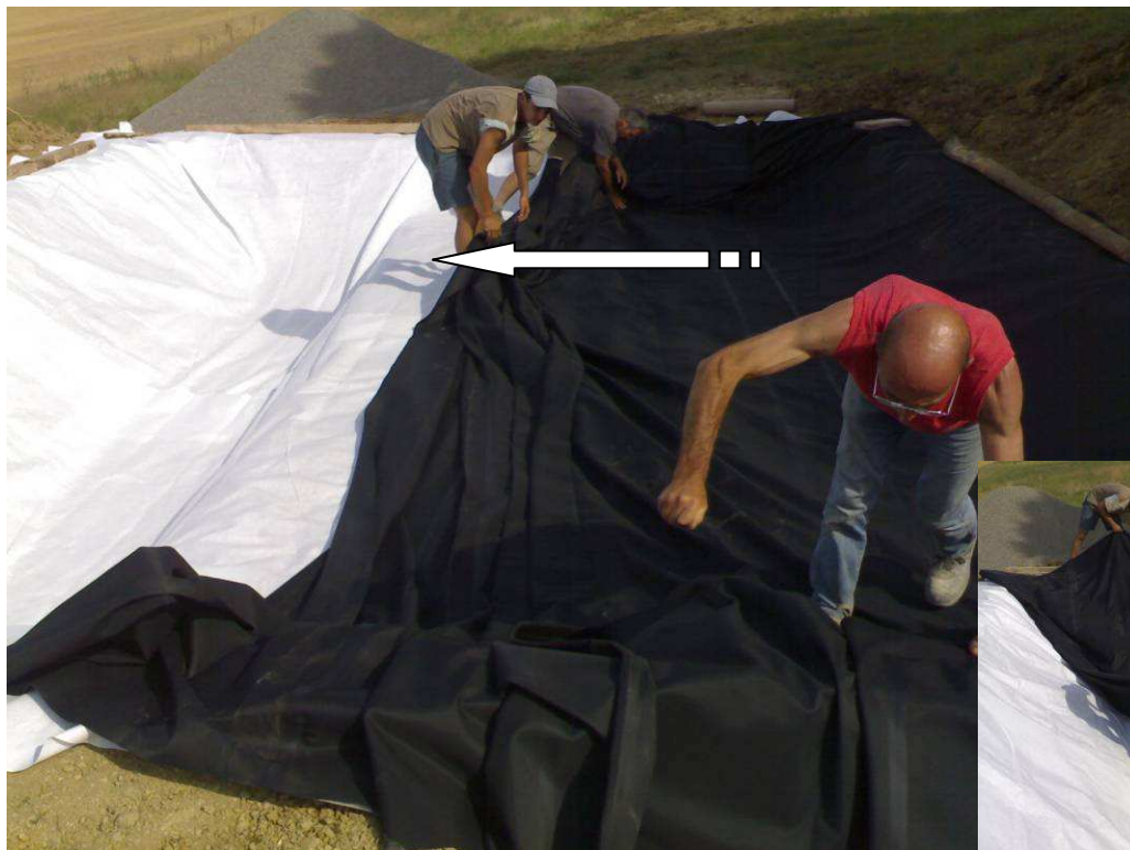
Photo 9 : mise en place de la bâche étanche en EPDM (3)
