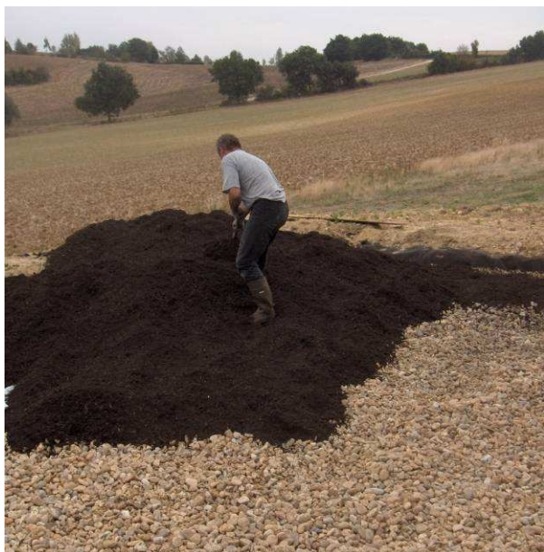
Photo 28 : mise en place du compost végétal (1)
