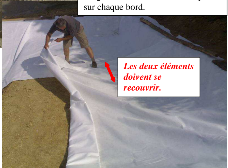
Photo 3 : Application du géotextile et recouvrement des lés (1)
