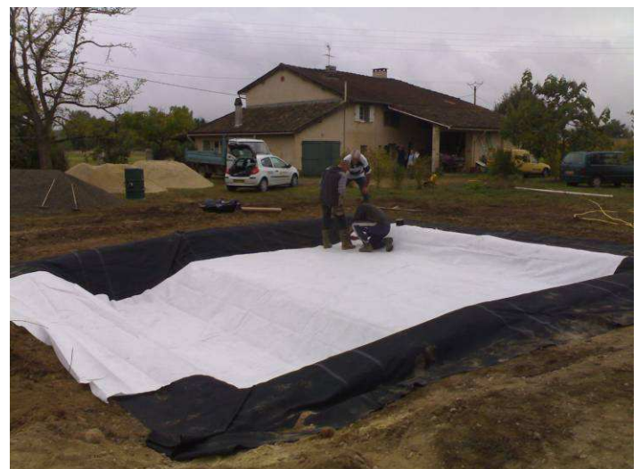
Photo 14 : pose du géotextile supérieur
