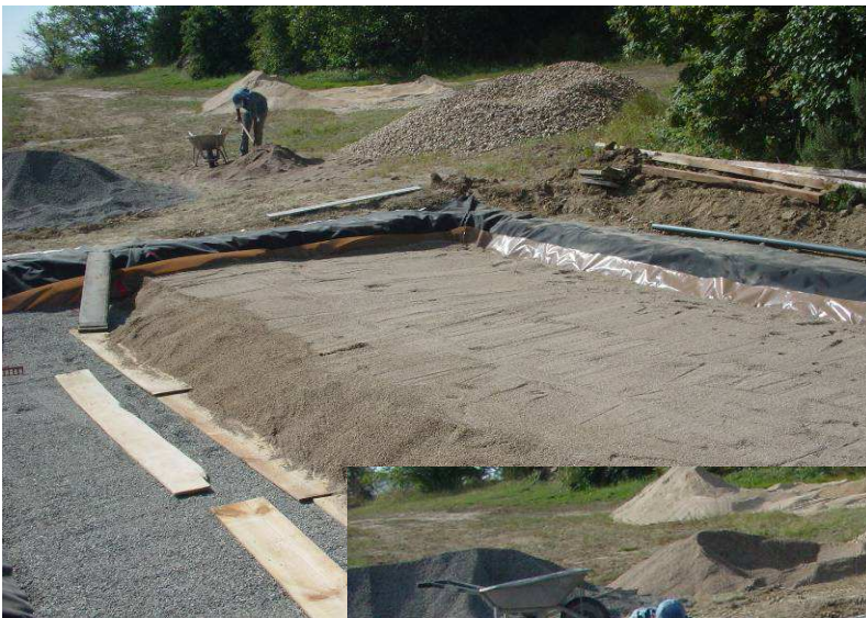
Photo 22: Réglage du niveau fini du filtre (1)
