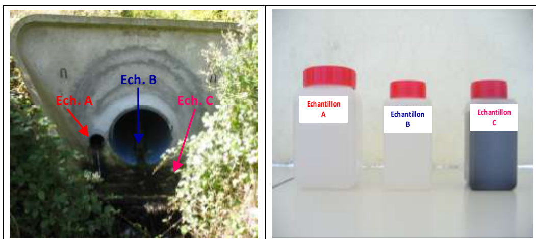
Figure 68 : Rejet issu de la zone commerciale se déversant dans la rivière Chaudanne, en amont immédiat de S4
