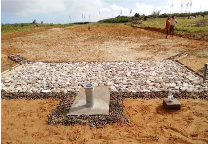
**QUOI :** Système de collecte et de récupération d'eau de pluie avec un stockage dans un réservoir enterré, étanchéifié rempli de granulats spécifiques. Le tout est équipé d'un système d'exhaure (Pompe manuelle)
